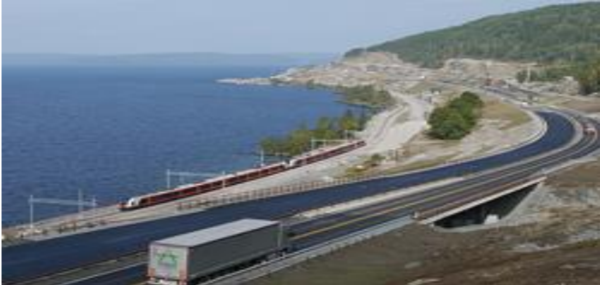
Figur 35 - Fra Fellesprosjektet ved Strandlykkja, september 2014.
