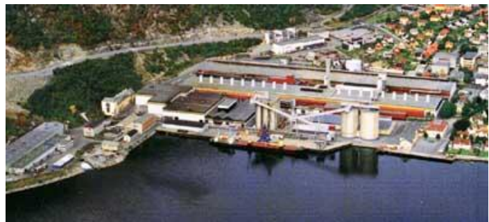
Figure 19: NORSK HYDRO Høyanger plant
