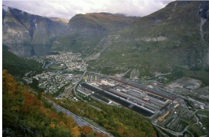
Figure 21: NORSK HYDRO Årdal plant
