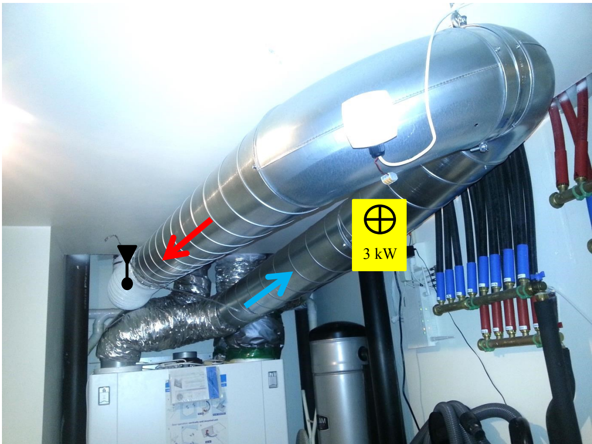
A. 8: Installasjon av varmebatteri i forlenging av tilluftskanal
