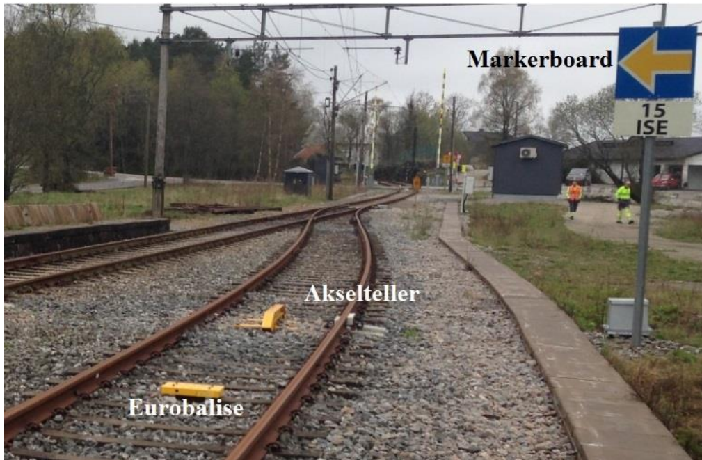
Figur 7.1 Objekter plassert i spor etter innføring av ERTMS
