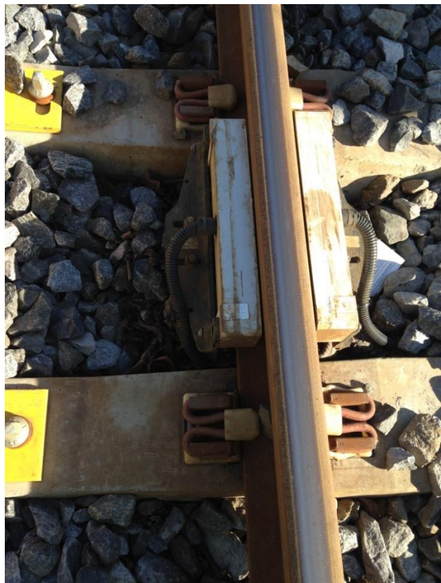
Figur 4.3 Akselteller av typen Bombardier på Mysen stasjon
