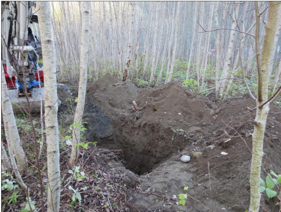
Figur 4.1.13: Oversiktsbilde over sjakt 4. Foto: privat.
