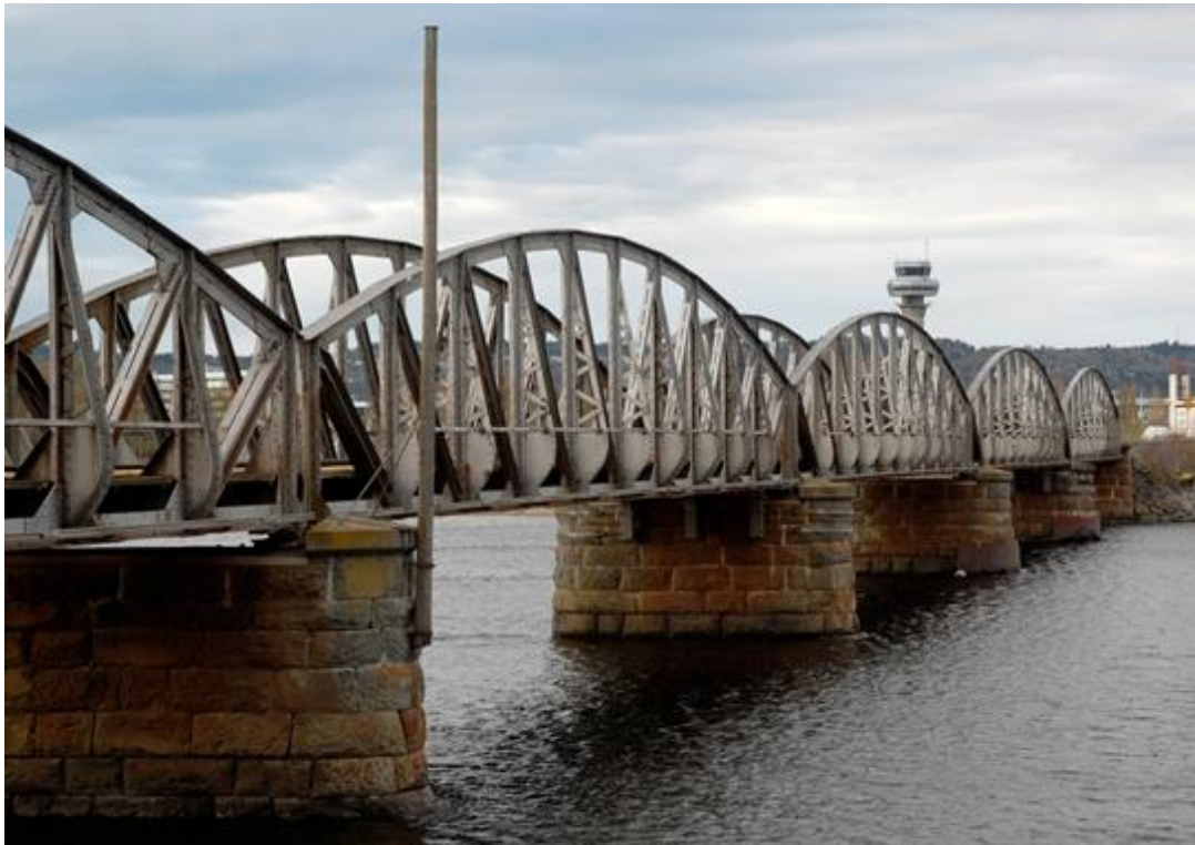
Figur 1.1 Hell Bru over Stjørdalselva. Foto: Jernbaneverket
