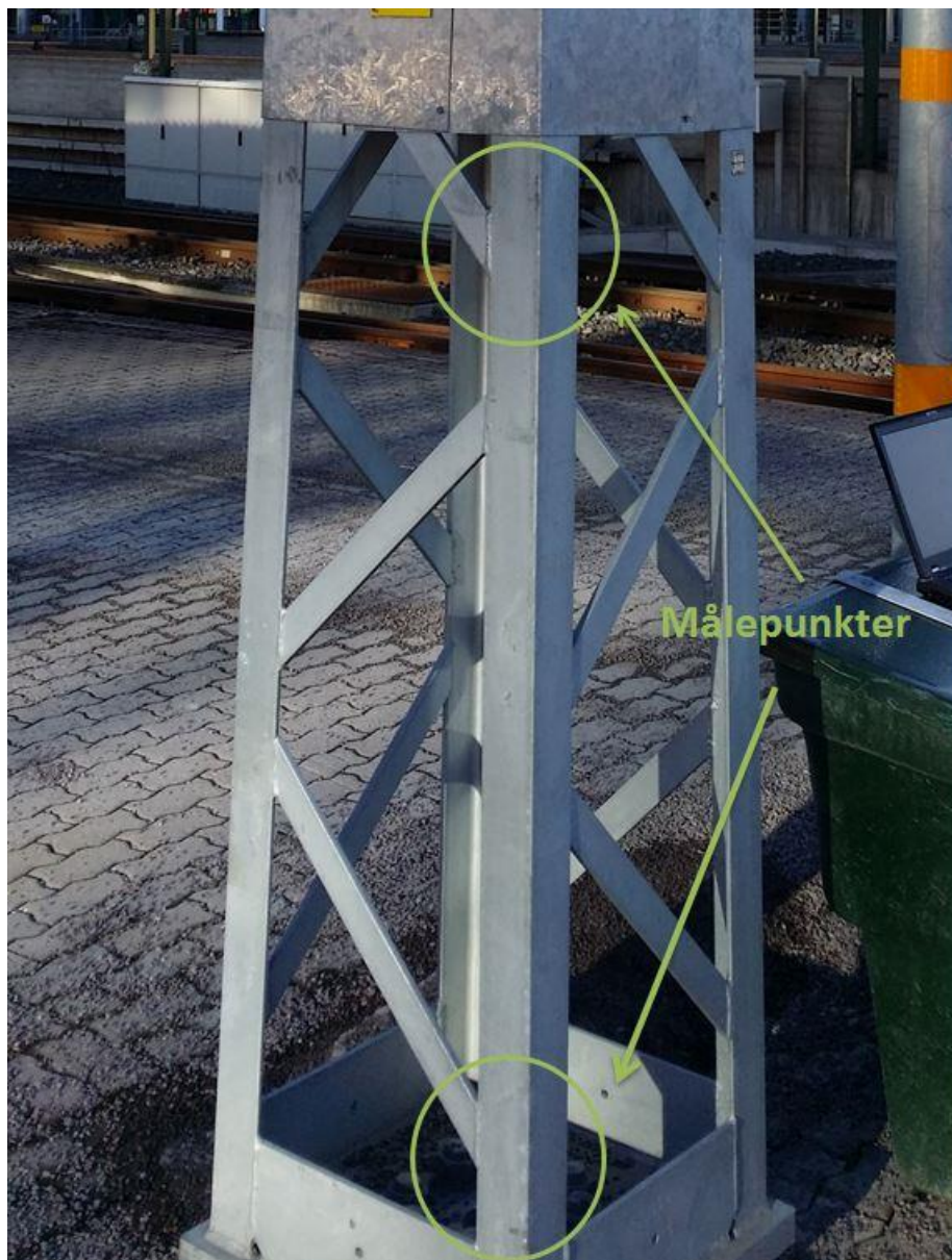
Figur 3-2 Målepunkter på H-master
