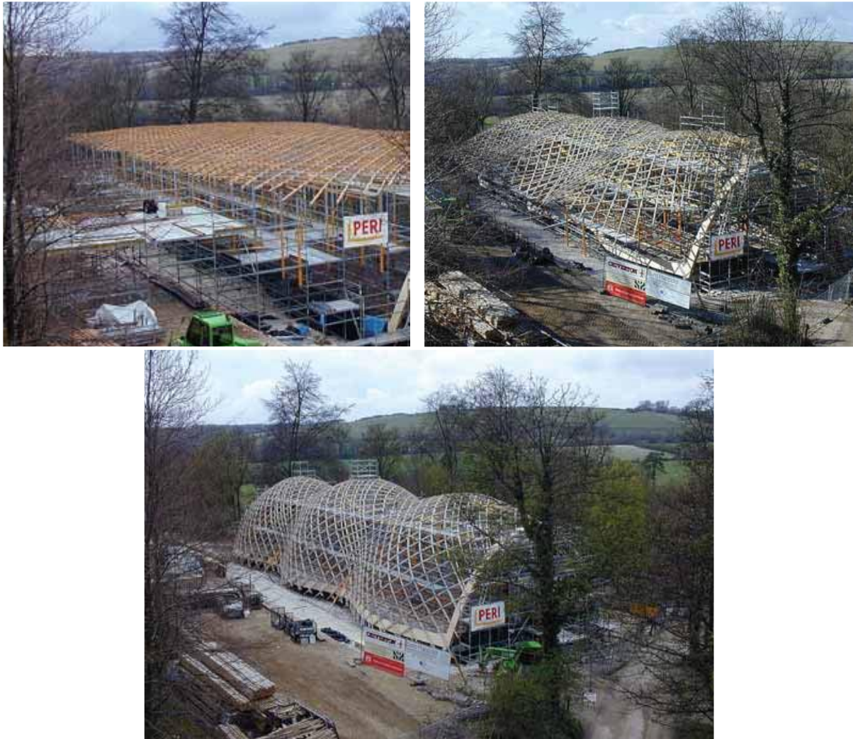
Figur 2.10: Oppføringen av Downland-skallet. Øverst t.v.: Flatt gitter på stillaser. Øverst t.h.: Tyngdekraft og jekkestropper drar skallet ned. Nederst: Ferdig skall
