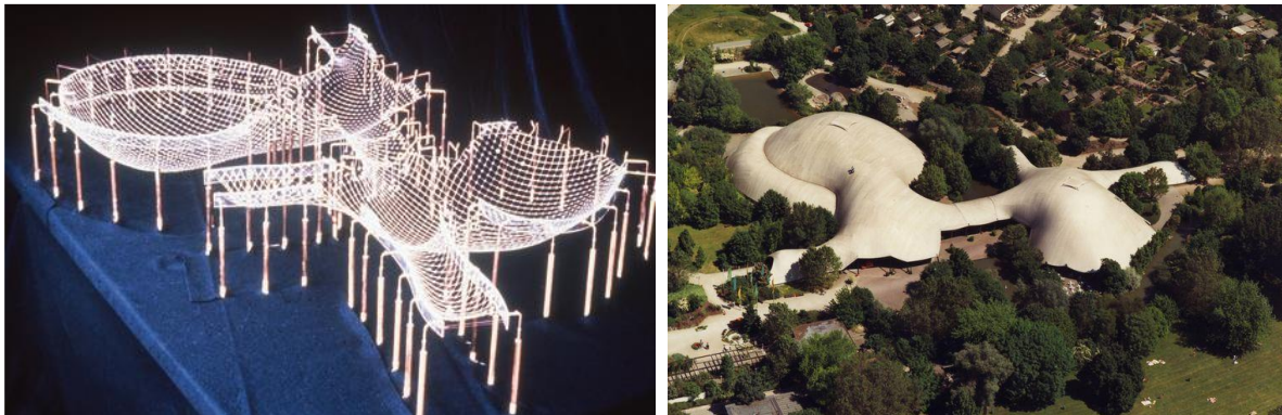
Figur 2.4: Trådmodell og ferdig konstruksjon
