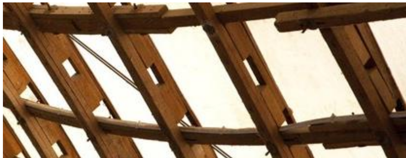
Figur 2.5: Fra Mannheim Multihalle: To-lags gitterskall med skjærblokker
