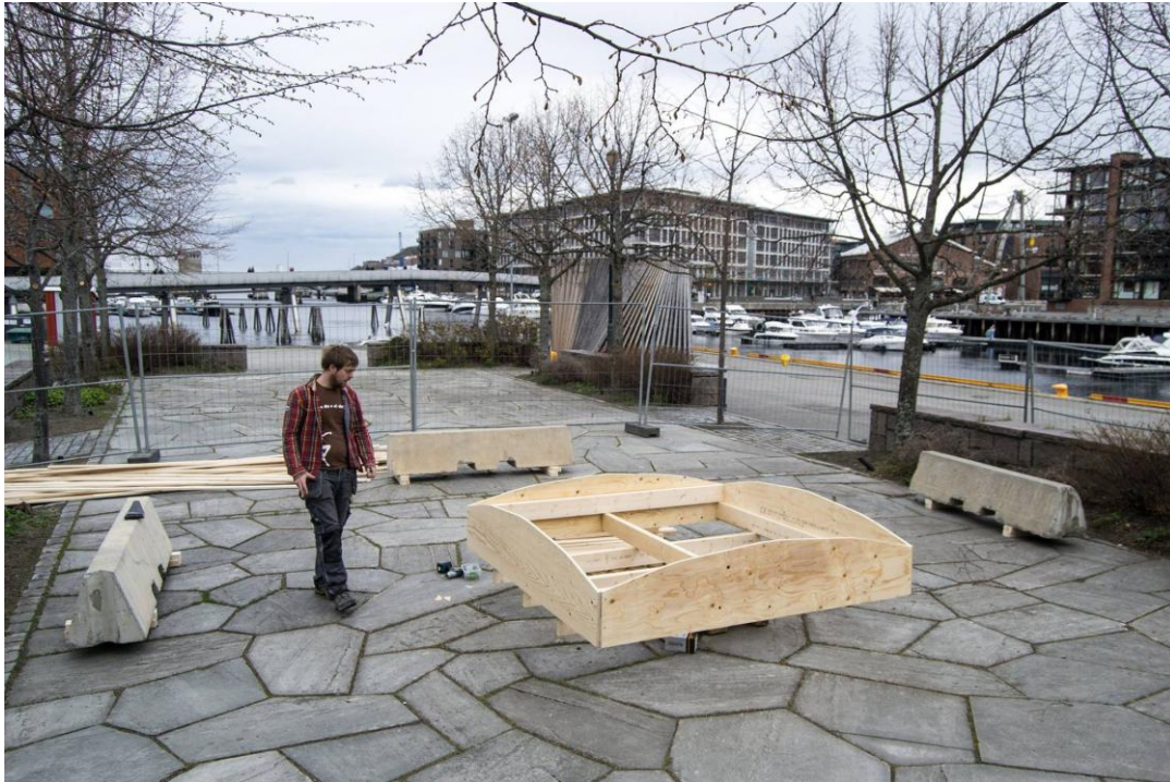
Figur 71: Sengen skallet skulle monteres på. Denne ble løftet opp av paller etter som arealet av gitteret økte [XX]
