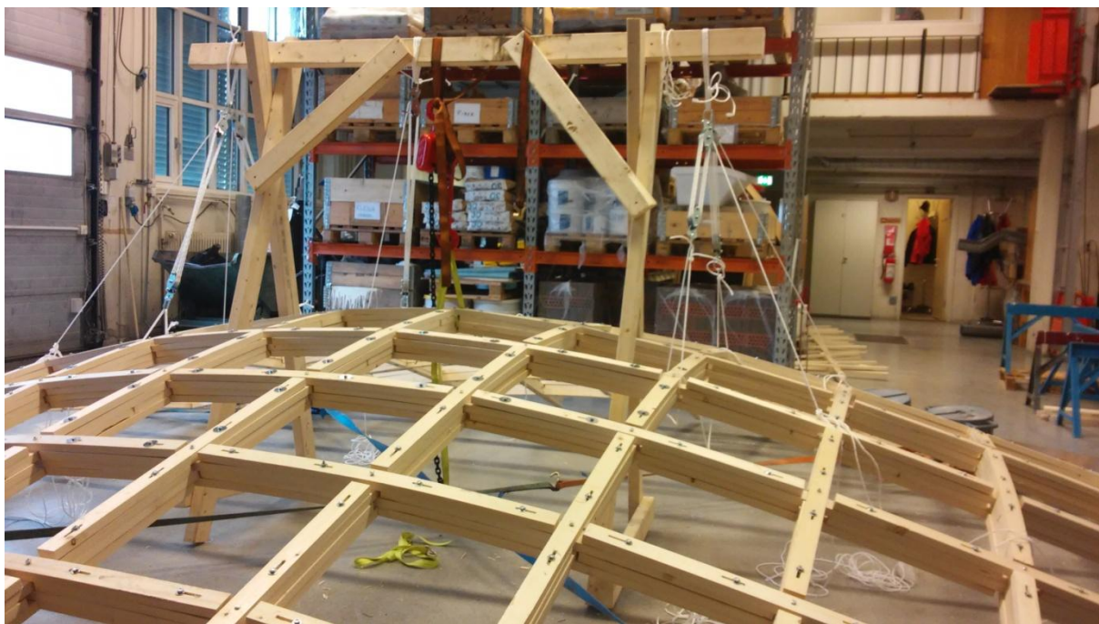
Figur 61: Stativ laget for å forsøke å heise skallet opp i form
