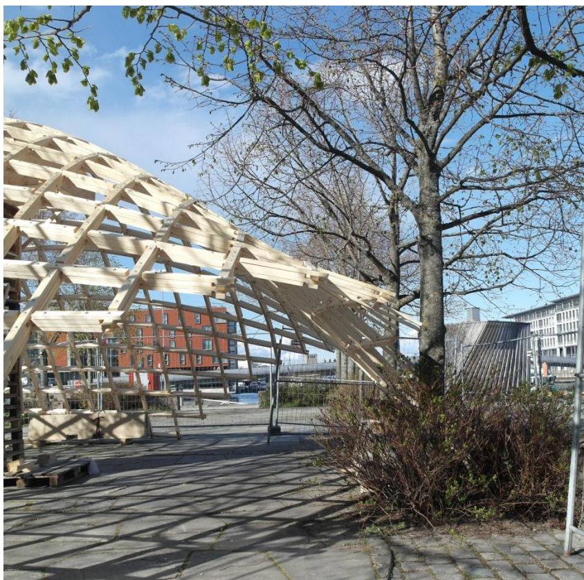
Figur 76: Observerer en lokal krumning i skallets bueganger
