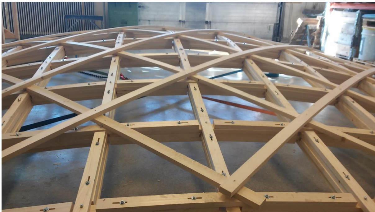
Figur 63: Diagonale avstivere montert på utsiden av skallet
