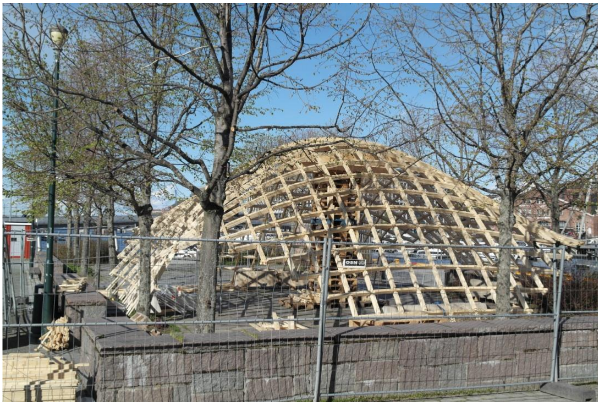
Figur 78: Skallet i begynnelsen av monteringen
