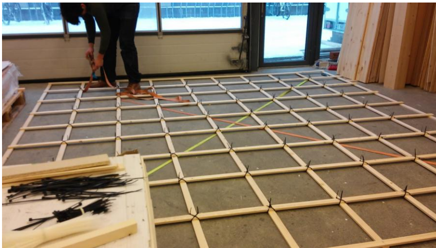
Figur 53: Gitter etter montering før bøyning
