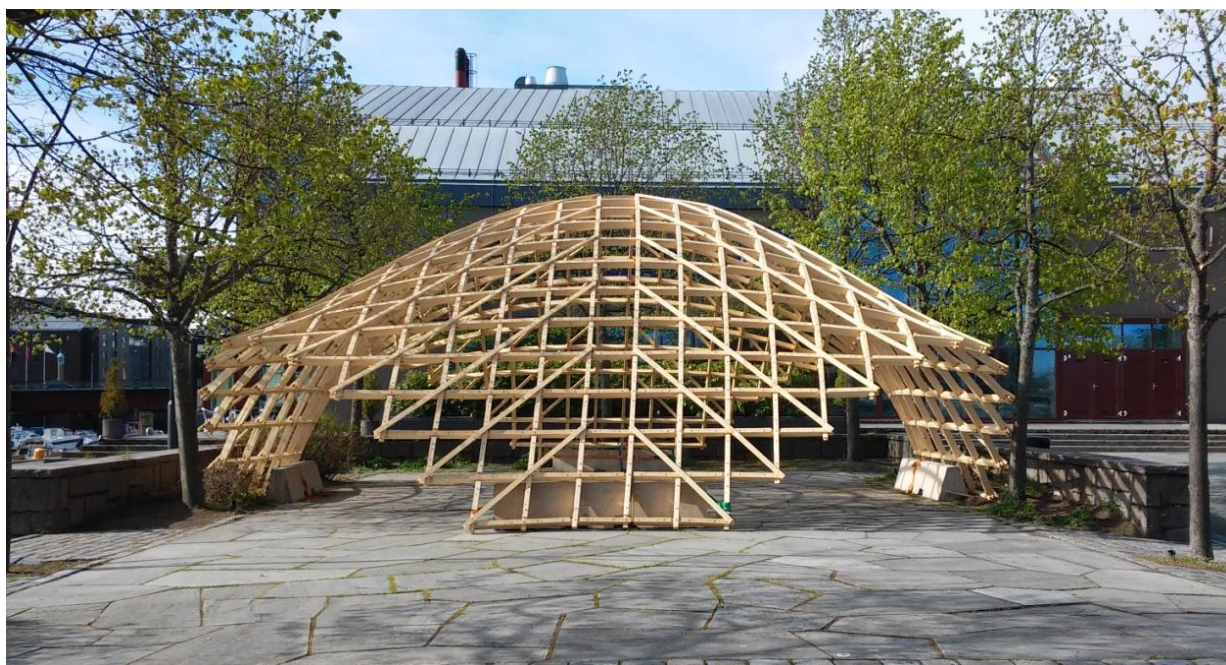
Figur 78: Skallet i begynnelsen av monteringen
