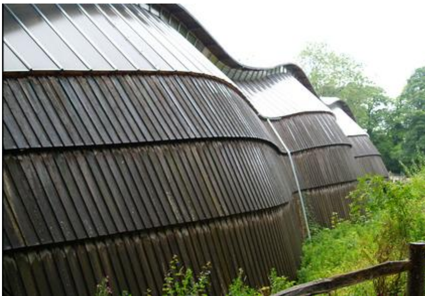
Figur 25: Gitterskallets fasade [XIV]
