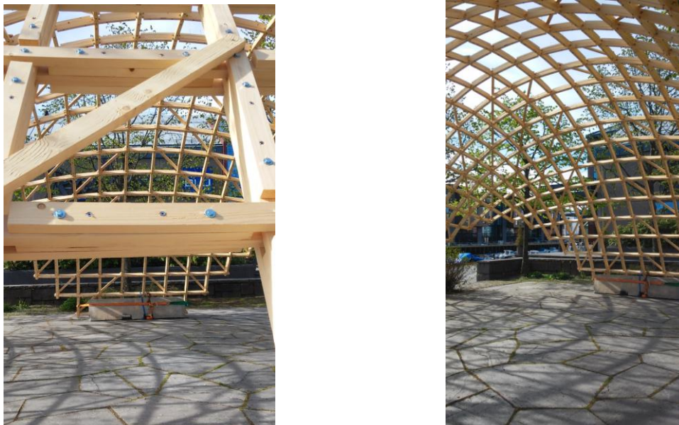
Figur 75: Randbetingelser er oppfylt og avstivere er montert
