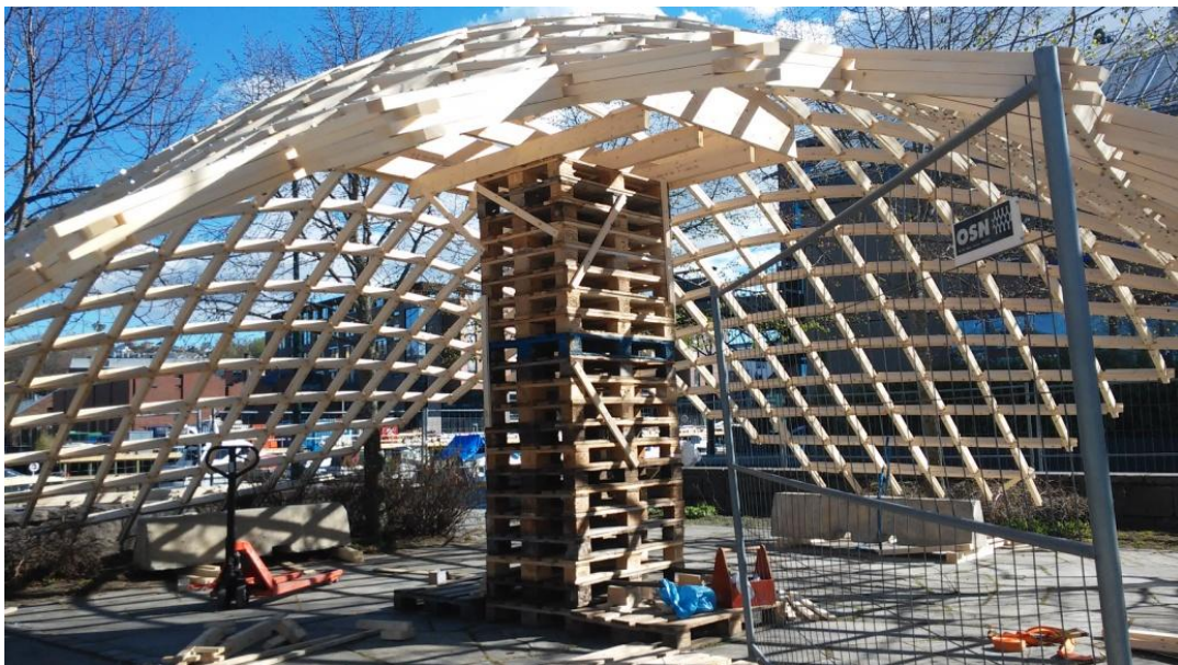
Figur 72: Skallet ble heist opp av paller ved bruk av jekketralle
