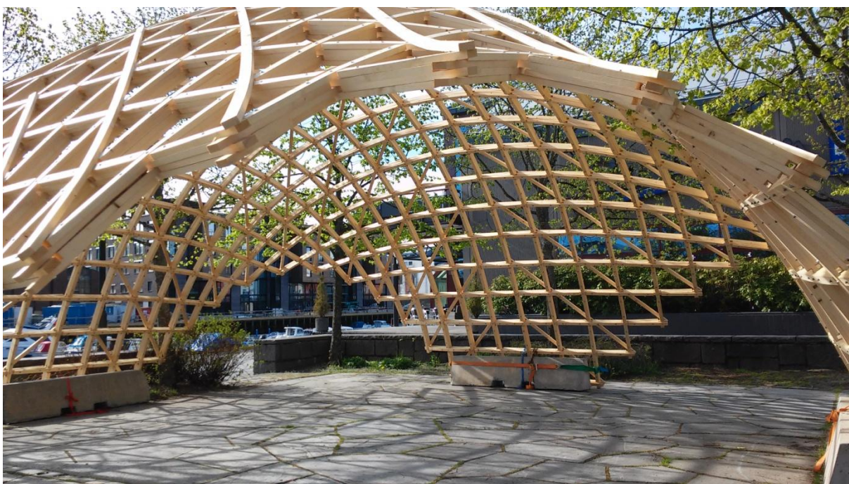
Figur 77: Observerer en lokal krumning i skallets bueganger
