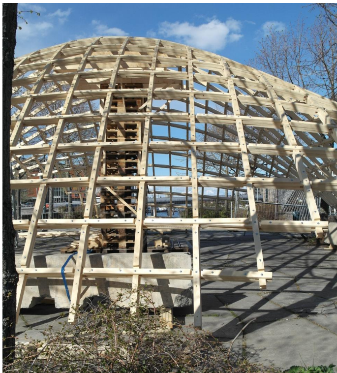
Figur 73: Betongblokkene lagt på plass men ikke festet til skallet enda. Vi oppdaget at formen var ganske nær den vi ønsket
