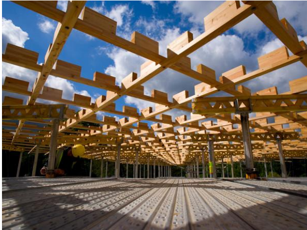
Figur 27: Bjelker og skjærblokker under byggeprosessen [XVI]
