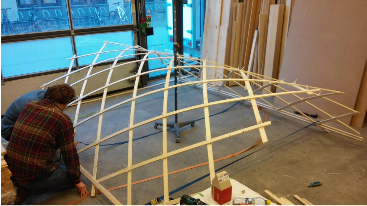
Figur 56: Gitteret bøyd ortogonalt i buegang
