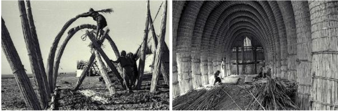
Figur 4: Under byggingen av en mudhif [IV] Figur 5: Innsiden av en mudhif [IV]
