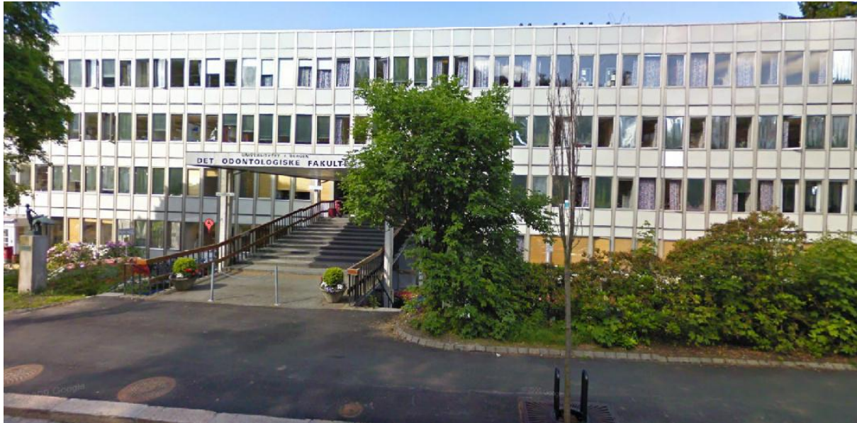
Figur 3.1: Frontfasade Gamle Odontologiske Bygg Bergen (Foto: Google Earth).
