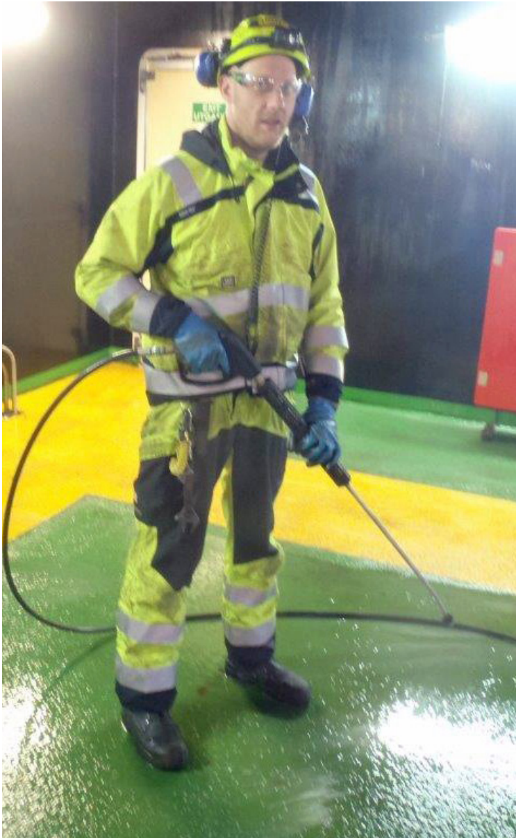
Pyrad-bekledningen gav god beskyttelse mot vind og fuktighet.
