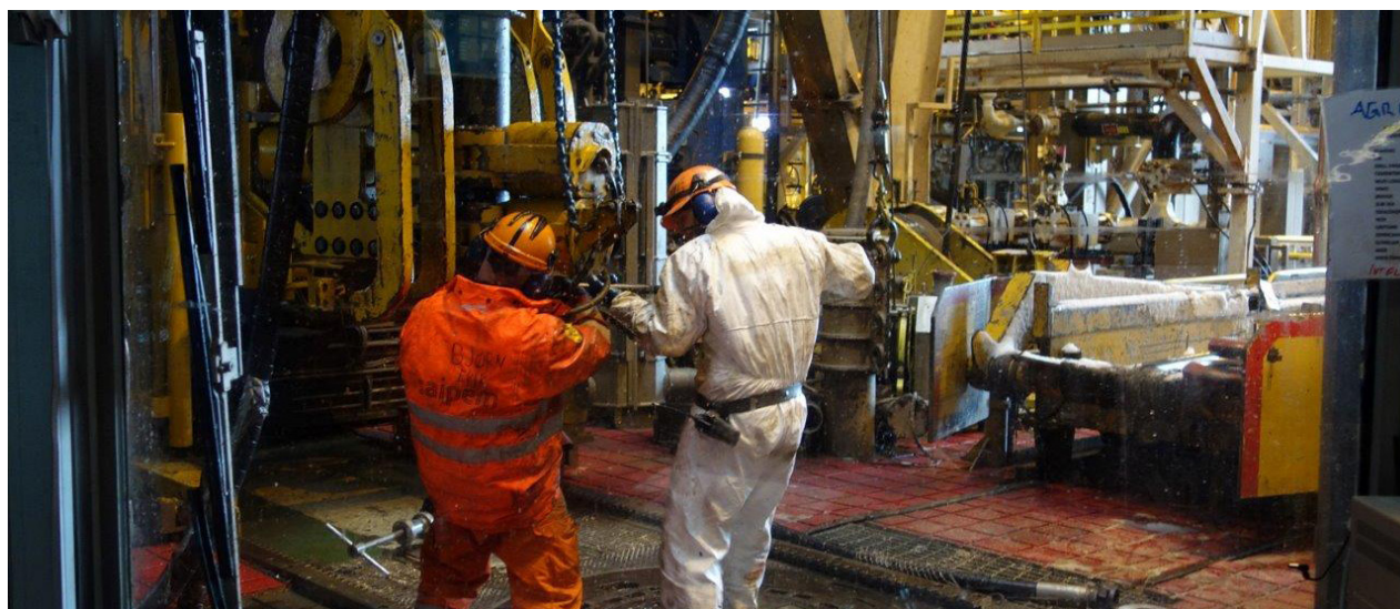
Boredekkarbeidere monterer boreutstyr. foto: SINTEF
