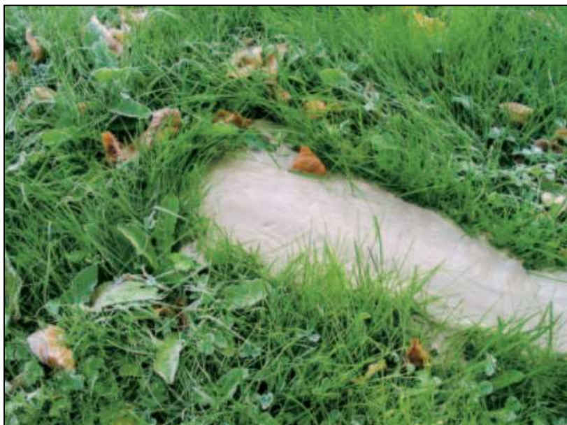
Figur 4.10 Injeksjonsmasse pumpet opp i dagen som et resultat av for høyt v/c tall (Klüver & Kveen, 2004)
