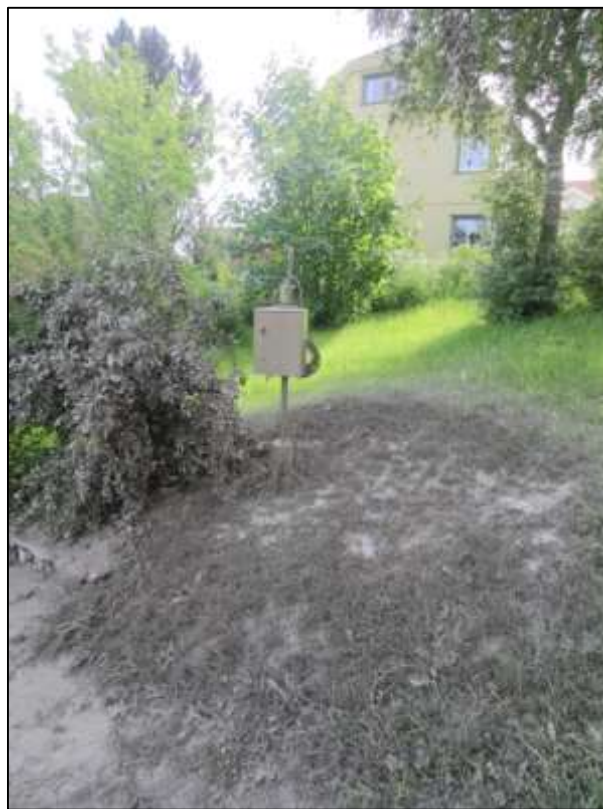
Figur 6.2 Utgang av injeksjonsmasse ved en grunnvannsbrønn (Gudmundsson, 2015)
