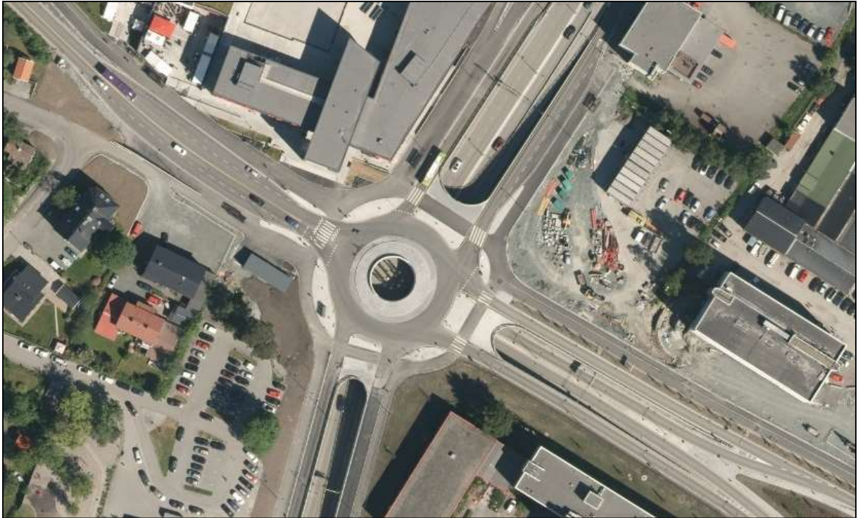
Figur 2.4 Flyfoto over Strinheimtunnelen utgang øst (Kartverket, 2015)
