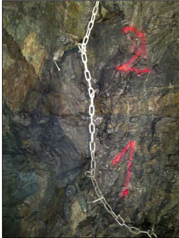
Figur 4.5 Pakkerfesting med kjetting ved Ringvei vest i Bergen (Hognestad, 2014).
