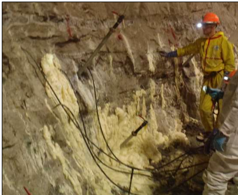
Figur 4.11 Injeksjon med polyuretan i Randolph Deep Mine (Ecogrout, 2012).
