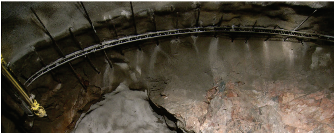
Figur 4-7: «Composite Pile Roofing» montert i forbindelse med tunnelprosjektet Yxhugget i Stockholm, Foto: Roland Ekenberg.
