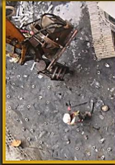
SCAVO DI POZZO SHAFT EXCAVATION
