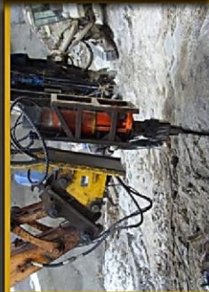
SBANCAMENTO ROCCIA OPEN ROCK EXCAVATION
