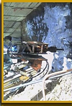
SCAVO DI TRINCEA TRENCH EXCAVATION
