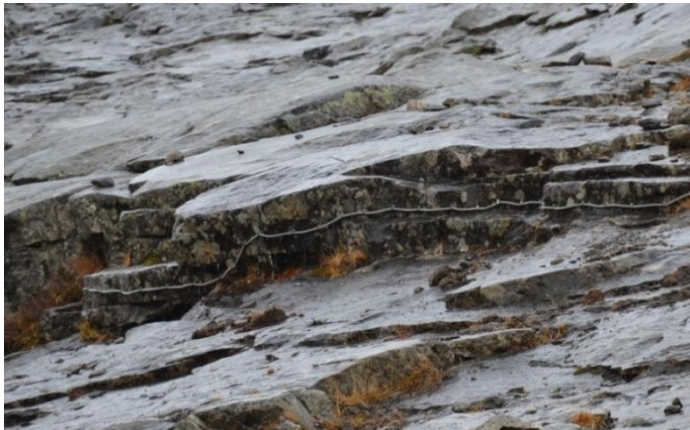
Figur 4.6 - Plassering av kabel bak formasjoner (t.v.) og frest ned og dekt til med mørtel (t.h.) (foto: Tore Humstad, SVV, 23. oktober 2014).
