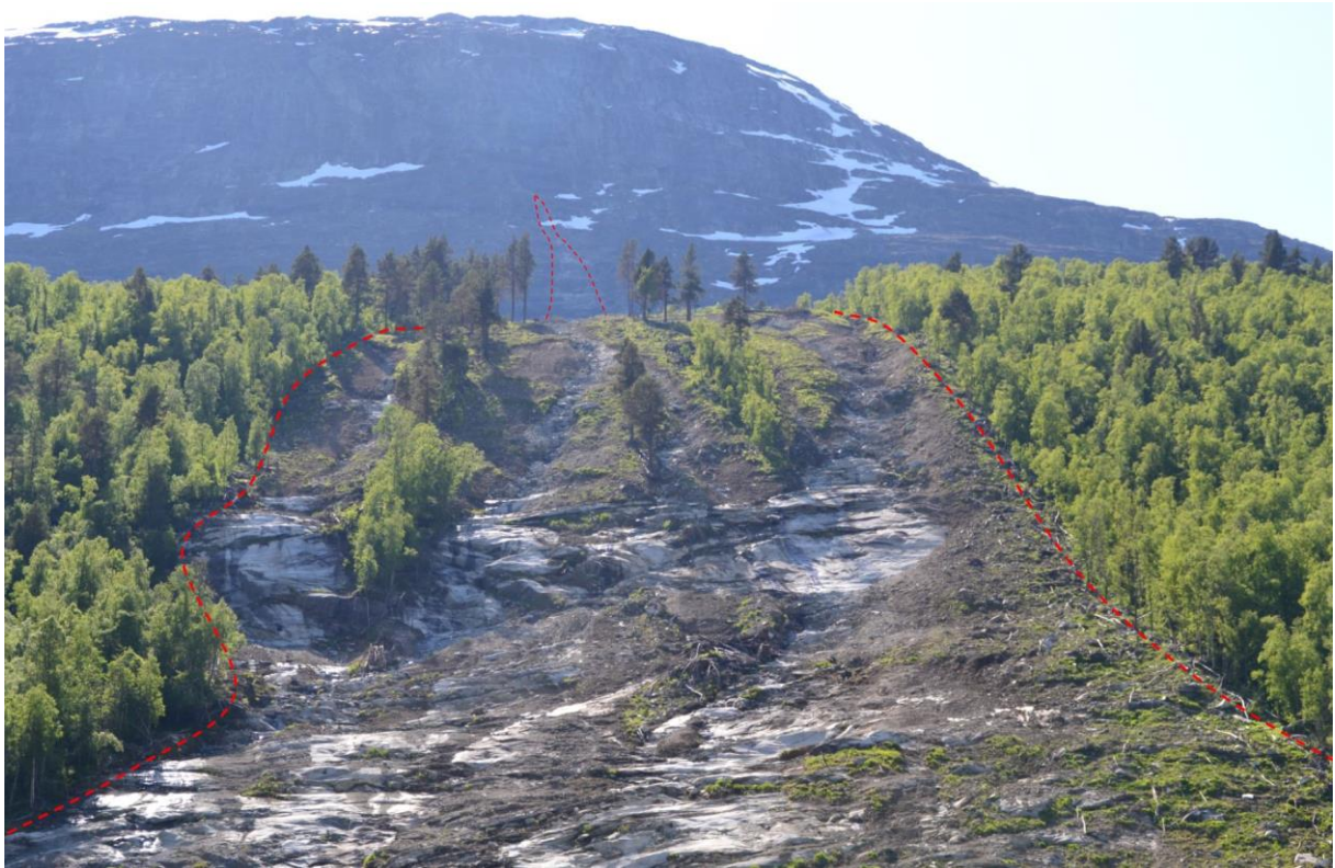
Figur 5.2: Oversikt fra bunn av skredet. Utløsningspunkt kan sees i bakgrunnen og rød stiplet linjer markerer yttergrensen for skredet. For skredlokalitetens plassering i Møre og Romsdal se Figur 5.1. For å se plassering av foto i forhold til skredet se Figur 5.3. (02.06.14)
