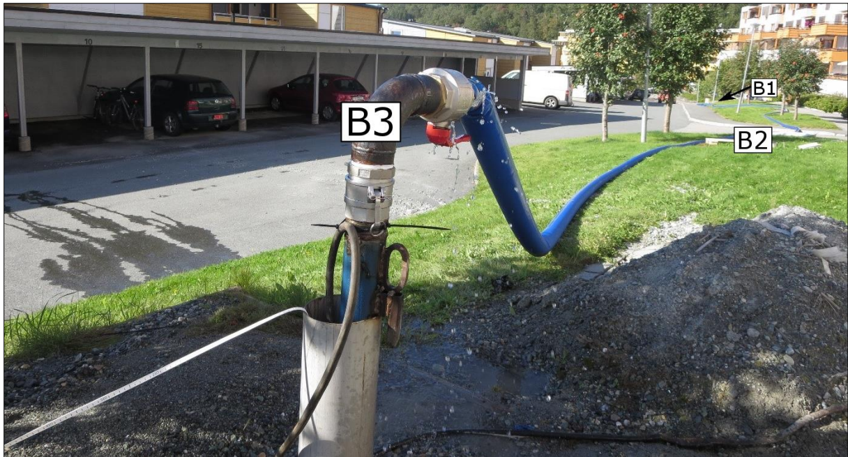
Figur 4.3 Oversiktsbilde fra Lena terrasse fra den første prøvepumpingsperioden. Grunnvann ble pumpet opp fra B3 og infiltrert i B1, B2 ble brukt som peilebrønn. Bildet er tatt mot nordvest. Modifisert etter foto av Randi K. Ramstad.
