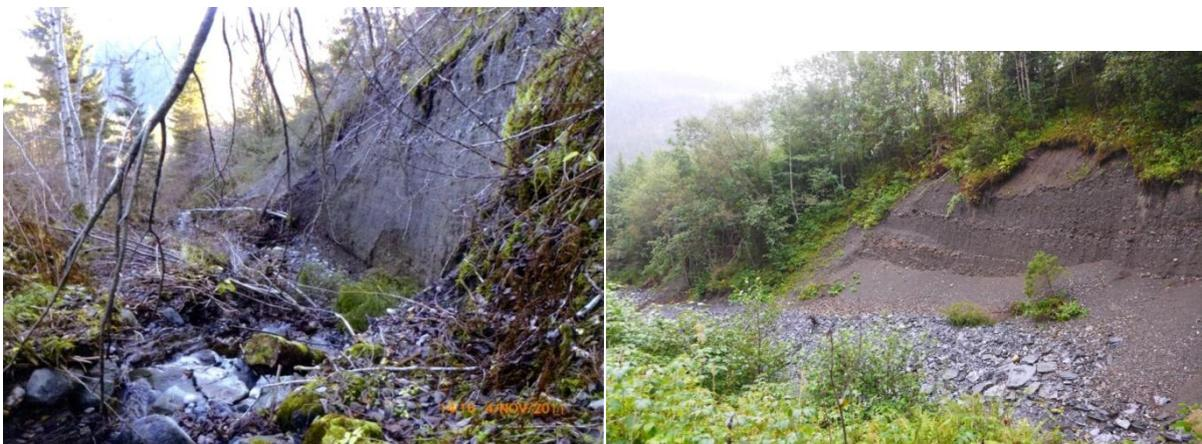
**Figur 40:** Delar av grusmelet før (venstre) og etter (høgre) tiltak
