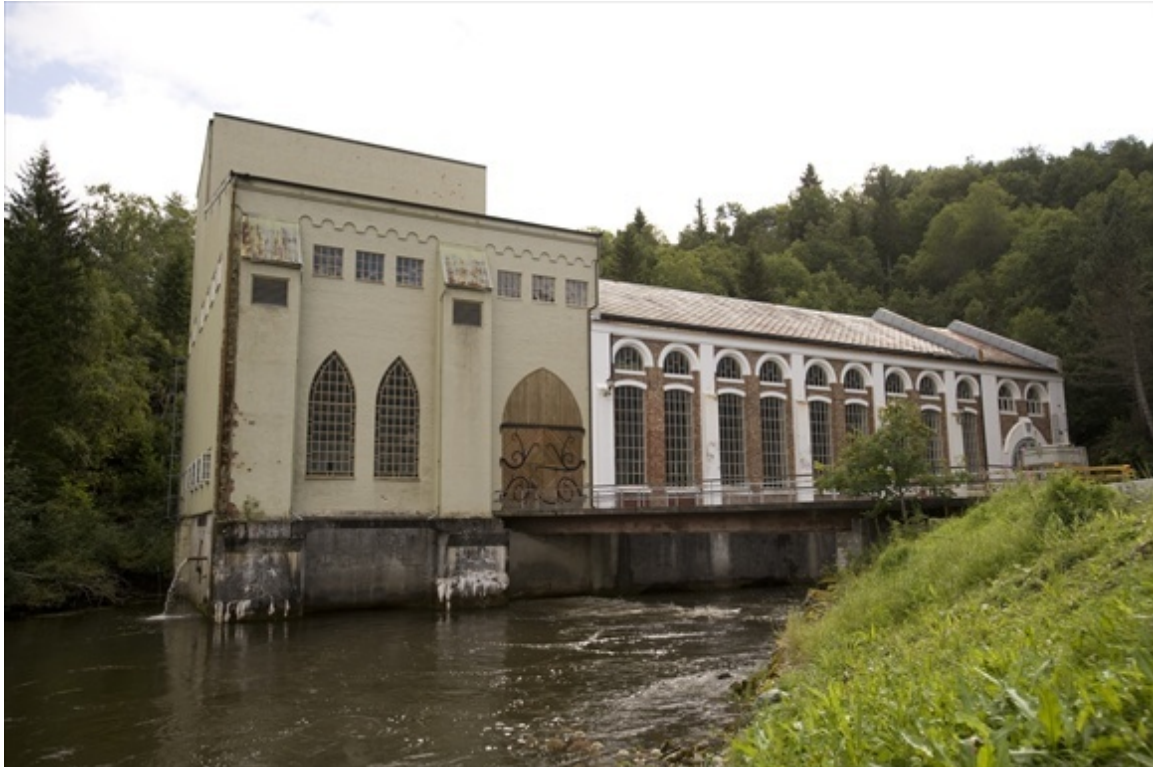
Figur 1: Øvre Leirfoss kraftverk [9]
