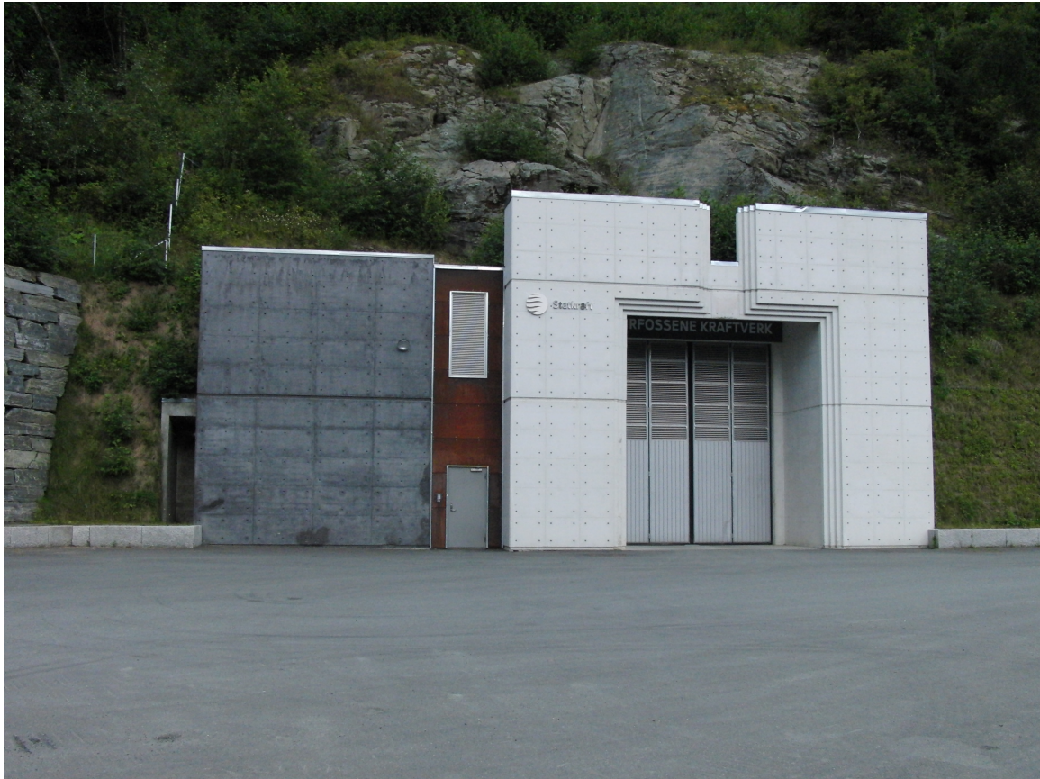
Figur 3: Inngangen til Leirfossene kraftverk [10]
