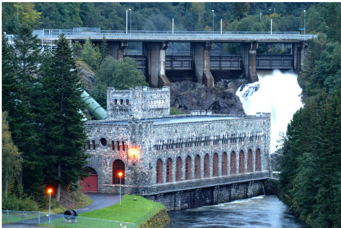
Figur 2: Nedre Leirfoss kraftverk [8]
