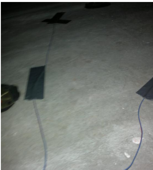
Figur 50 Termoelement plassert på overflaten til betongen i plenumet, 2
