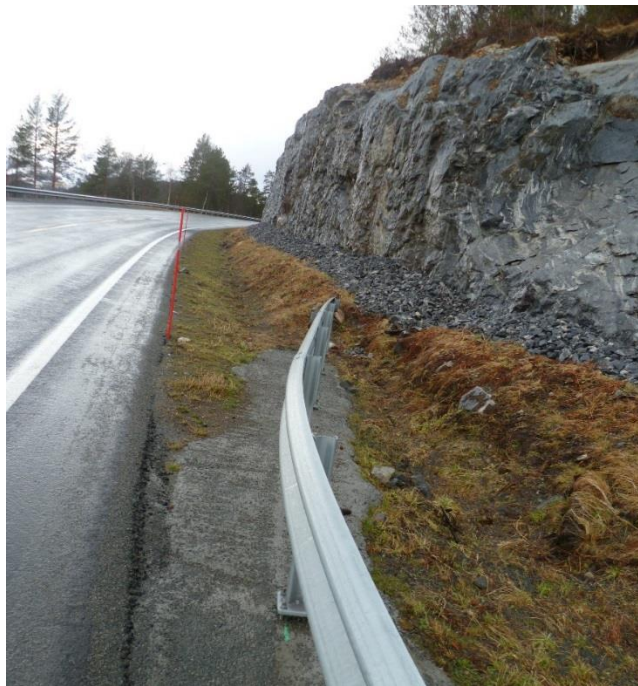
Figur 9. Avslutning av rekkverk på E39 Kvivsvegen, Foto: Kvalsvik.
