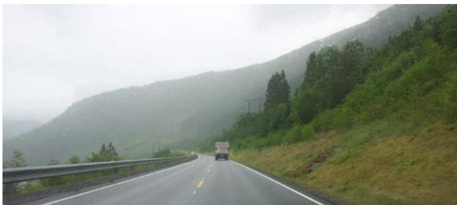
Figur 14. Grunne grøfter og sidebratt terreng på Fv 653 Eiksundsambandet, Foto: Kvalsvik.
