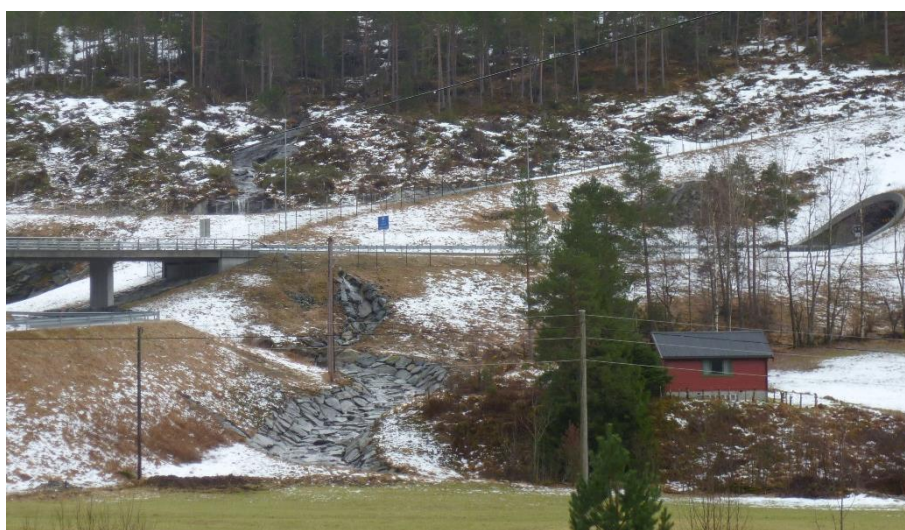
Figur 18. Plastra nedløp som er ført til resipient, E39 Kvivsvegen, Foto: Kvalsvik, 2015.
