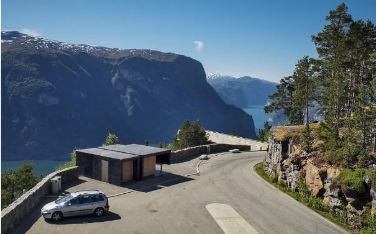
Figur 3.6: Parkeringsplass og toalettbygg på Stegastein. Utsiktsplattformen vises i bakgrunnen. Arkitekt (toalettbygg): Todd Saunders / Saunders & Wilhelmsen. Foto: Jarle Wæhler, Statens vegvesen (Nasjonale turistveger, 2015a).
