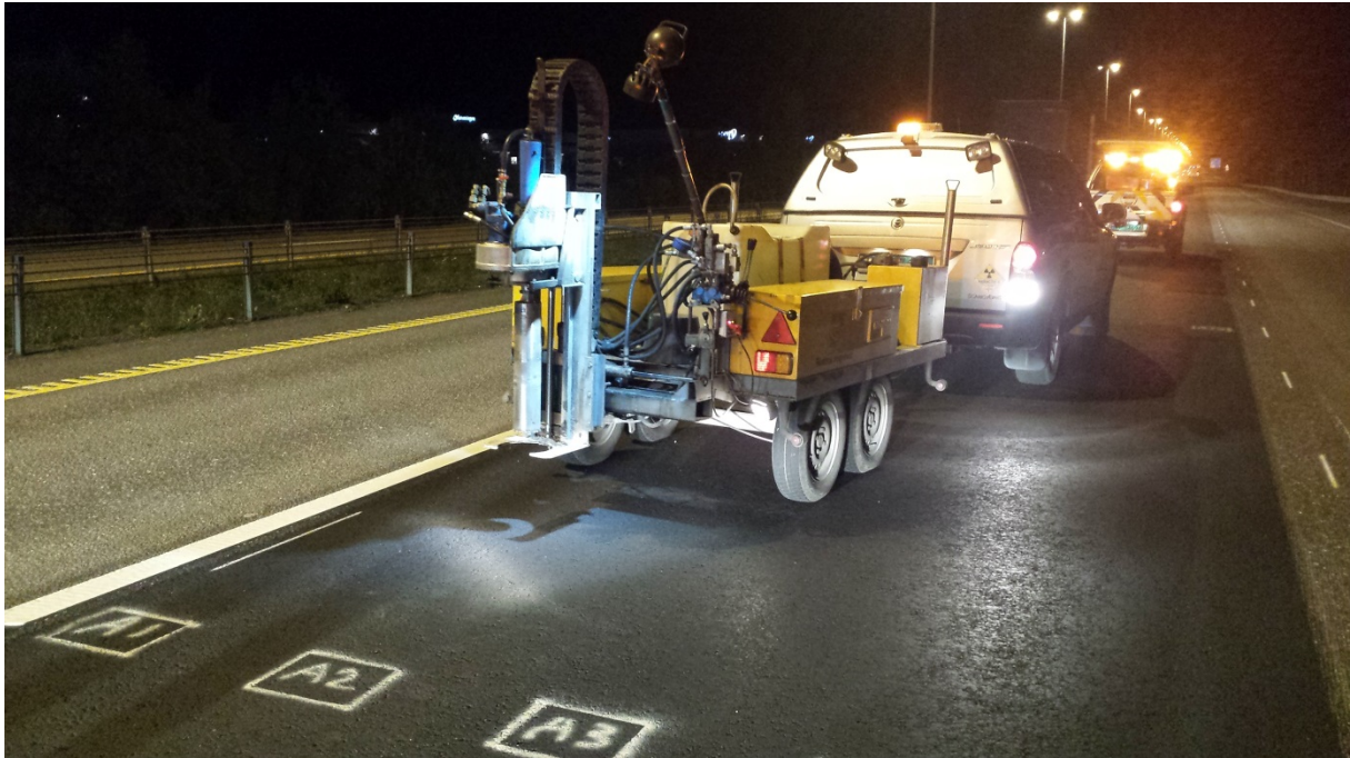
Figur 3.7 Boret kjøres innpå det anmerkede uttakspunktet
