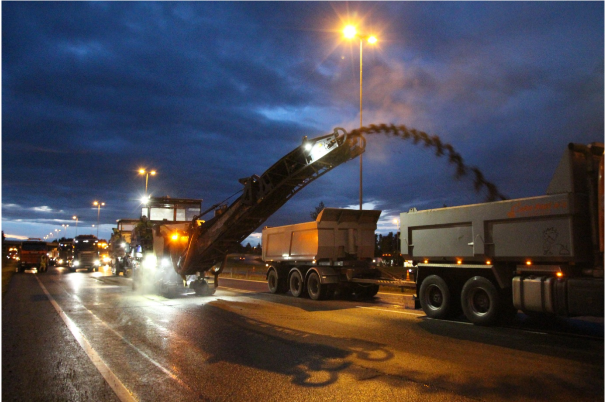
Figur 3.3 Fresing av gammelt slitelag på E6 i Romerike (Foto: Karoline Vaager)
