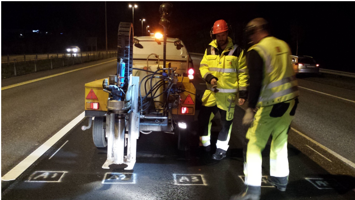
Figur 3.8 Viktor Hedfors (venstre) og Roy Støverud (høyre) fra Statens vegvesens Sentrallaboratoriet i Oslo gjør seg klar til å bore ut den første prøvekjernen
