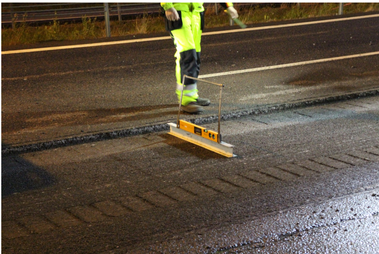
Figur 3.5 Fresetrauet etter fresing og rengjøring (Foto: Karoline Vaager)
