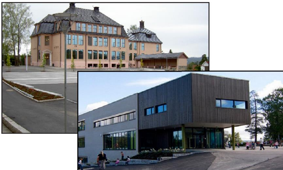
Figur 8 - Høybråten skole (Høybråten Velforening, 2008 og VVSforum, 2013)
