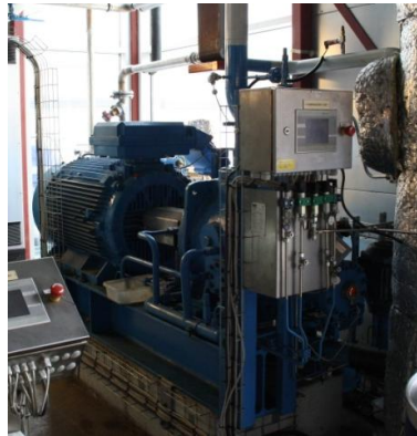
Figur 9. Høytrykkskompressor HOWDEN WRVXS 204/110 2,2.
