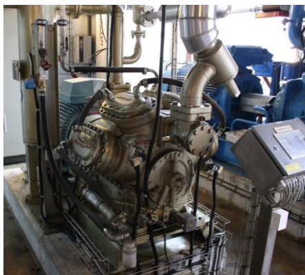
Figur 7. Lavtrykkskompressor MYCOM N8L.
