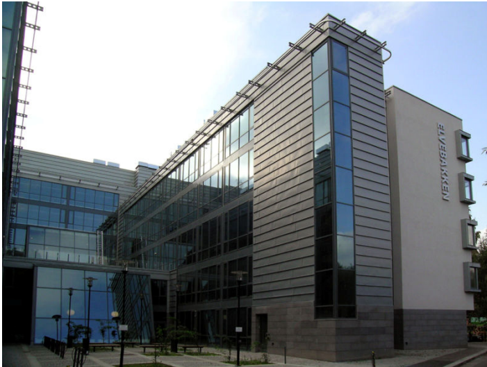
Figur 15: Baksiden av skolen mot Akerselva.
