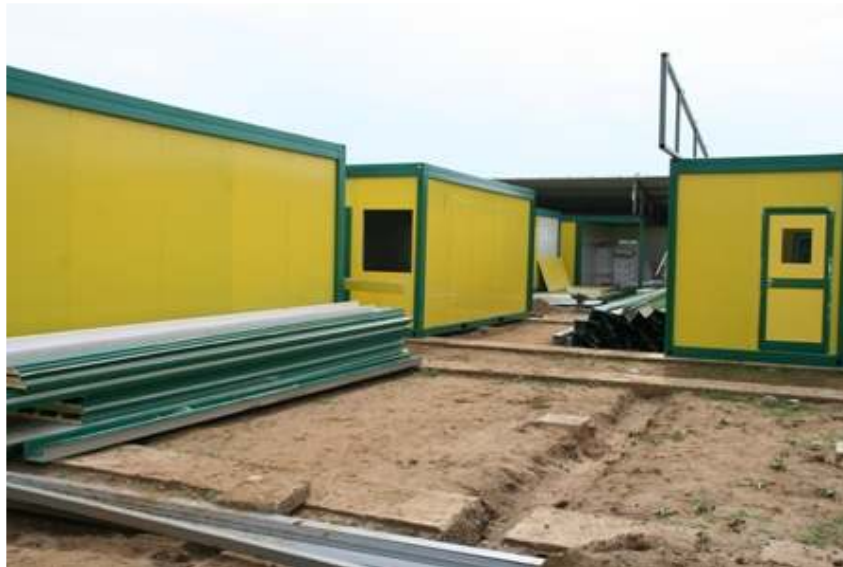
Container moduler som sykehuset er satt sammen av.
