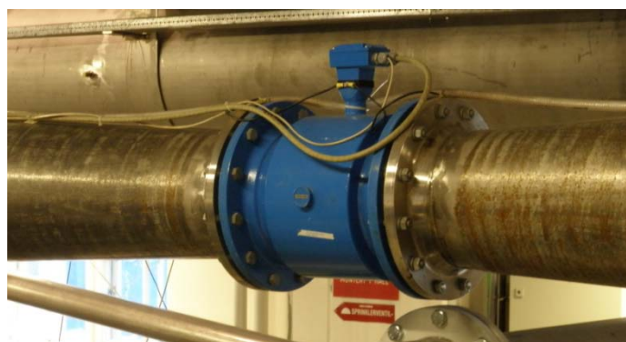
Figur 3-3: Elektromagnetisk volumstrømmåler
