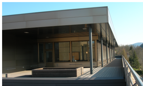
Bilde 3-3 5. Etasje på Kaffehuset Friele Bildet viser sør- og østfasade til 5.etasje
