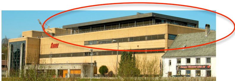
Bilde 3-1 Kaffehuset Friele, hvor 5. etasje er øverste etasje her markert med rødt.
