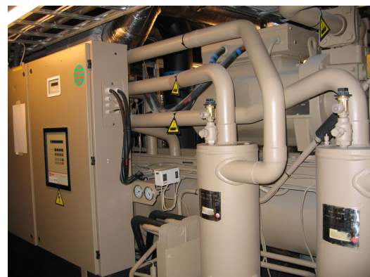
Figur 2.4: Kjølemaskin/varmepumpe.
