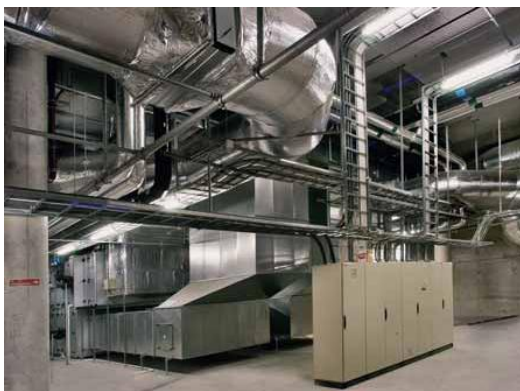
Figur 2.3: Ventilasjonsaggregat.
