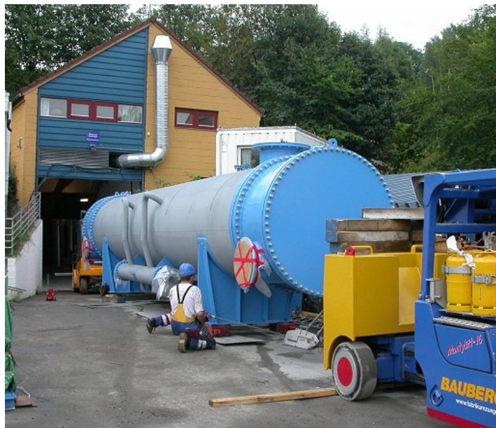
Figur 2-10 Bilde av fordamper VP1 tatt under montering (Viken Fjernvarme AS, 2007)
