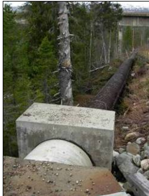
Bilde B-6 Overgang fra ny til gammel rørgate
