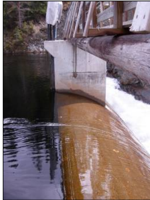
Bilde B-2 Nærbilde av dam med overløp
