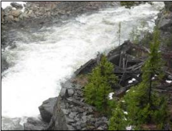
Bilde B-11 Rester av kraftverket fra 1905
