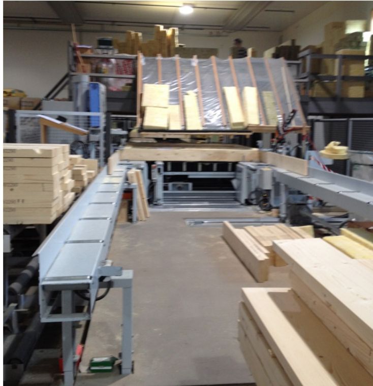
Figur 4.8. Stasjon for montering av bindingsverk og stasjon for kapping av isolasjon.
