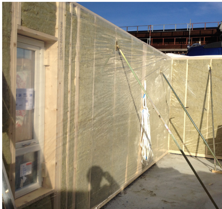
Figur 4.18. Ferdig montert veggelement.
