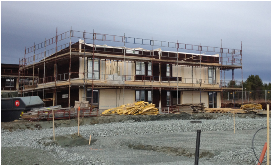
Figur 4.21. Bygget etter montasje av vegger.
