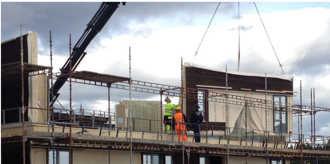
Figur 4.25. Risikofylt arbeidsoperasjon: montasje av element.
