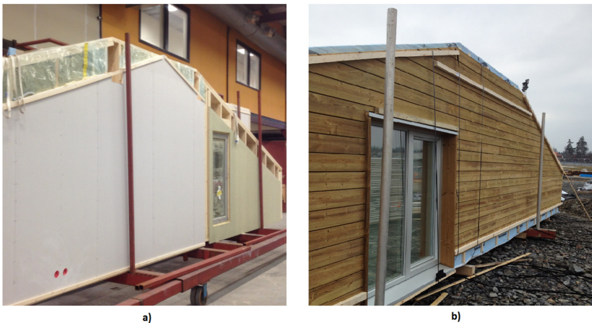
Figur 4.17. Avkappet møne a) Under produksjon b) Klar for montasje
