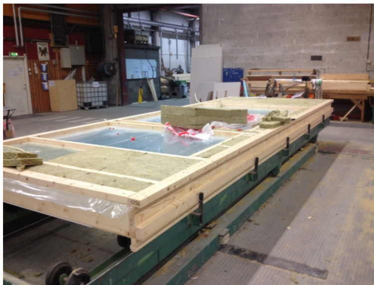
Figur 4.2. Montasjebenk for montering av bindingsverk.
