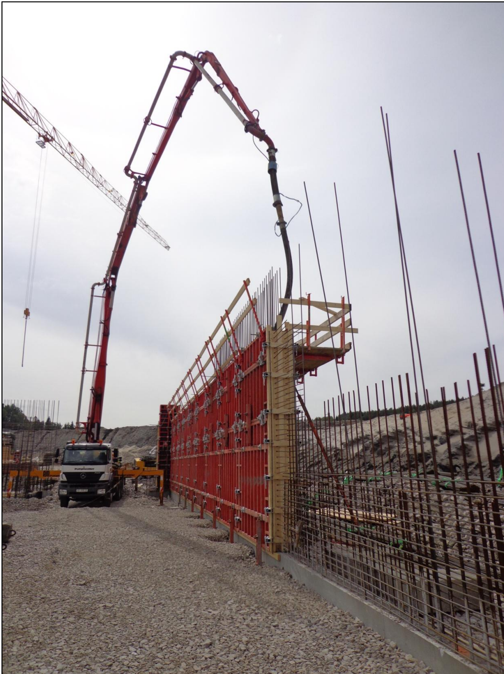
Figur 8 Veggforskaling. Foto: Tom-Erik Sørensen
