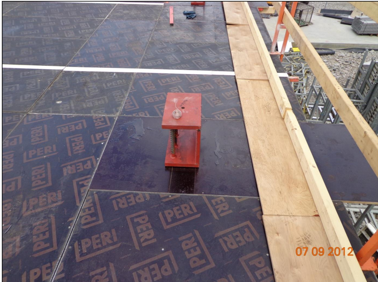
Figur 9 Bærende dekkeforskaling. Foto: Trond Segerblad
