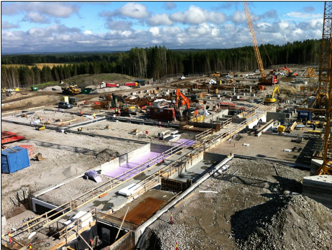
Figur 20 Eksempel på stor byggetomt: Sykehusutbyggingen i Sarpsborg. Foto: Tom-Erik Sørensen
