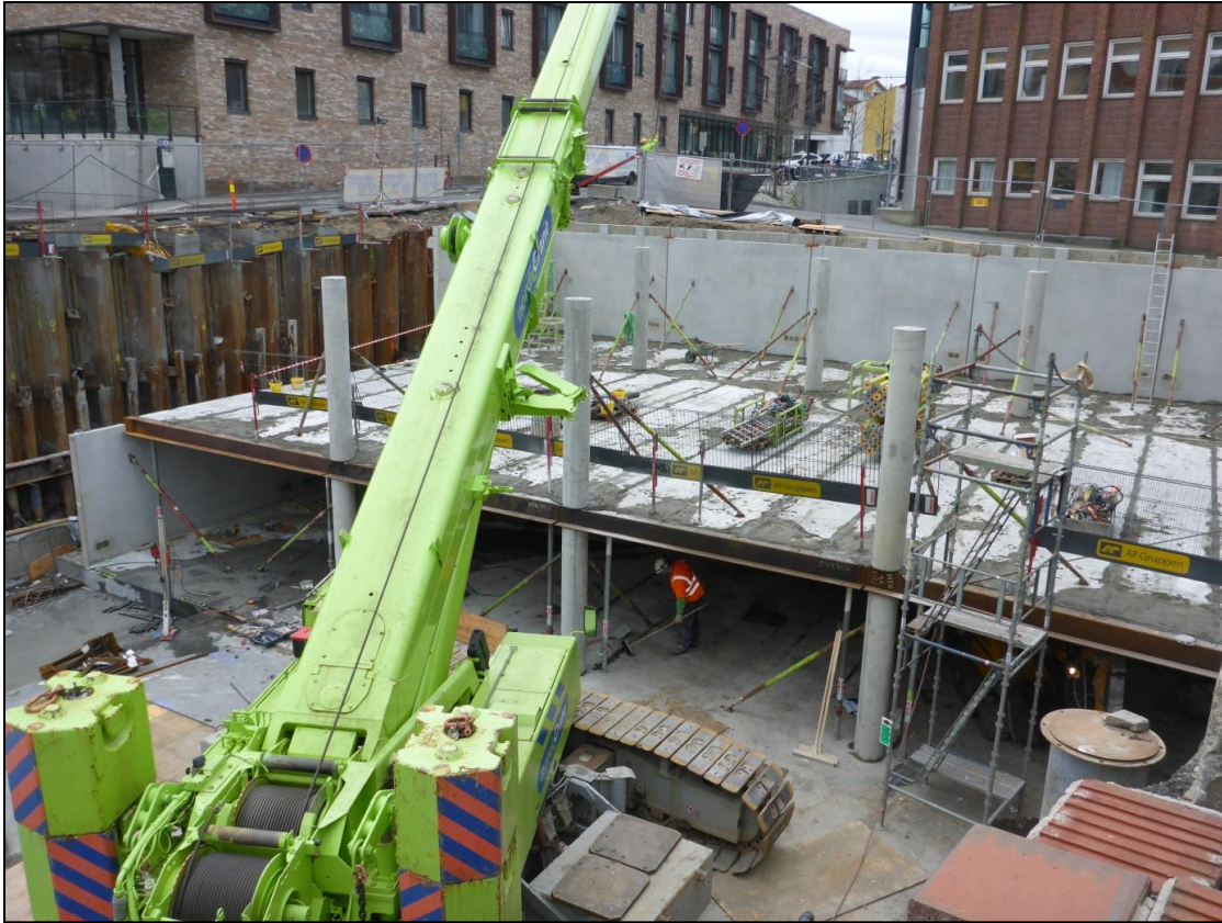
Figur 21 Eksempel på trang byggetomt: Kontorbygg for Statens Vegvesen i Moss.
