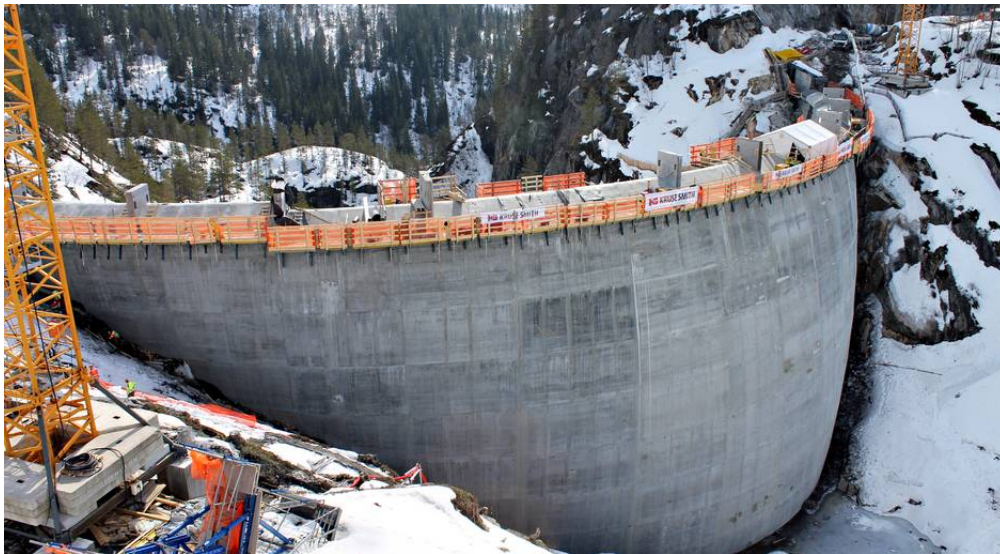
Figur 1.1: Dam Sarvsfossen kort tid før ferdigstilling [10]
