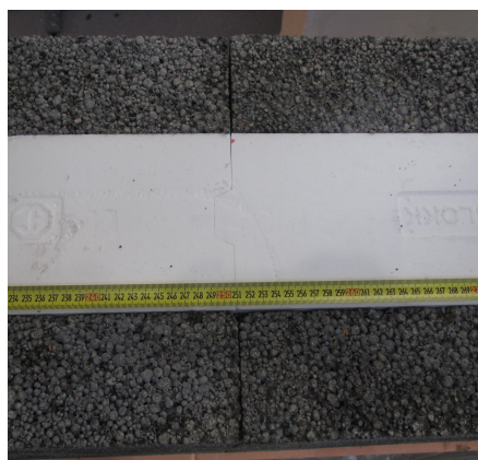
Figur 9 – Åpen stussfuge, ca. 4 mm.
