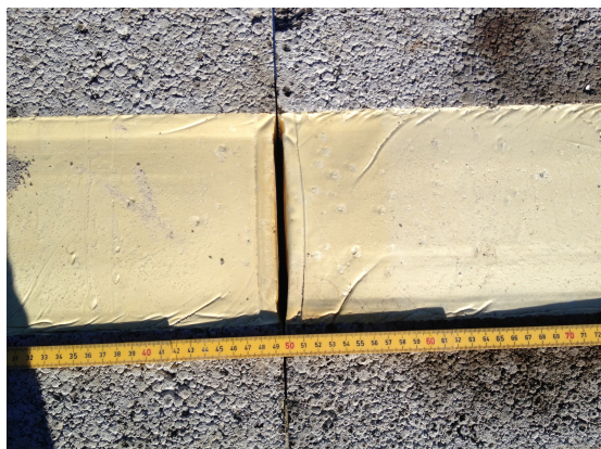
Figur 16 - Åpen stussfuge mellom isolasjonsskjernene. Horisontalsnitt.
