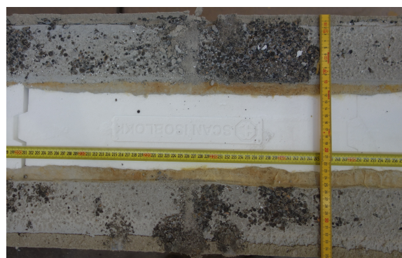
Figur 8 – Mørtelfuger murt med mørtelkasse.
