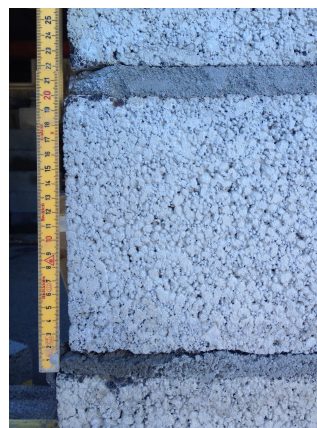
Figur 13 – Fugetykkelse, kjellervegg.
