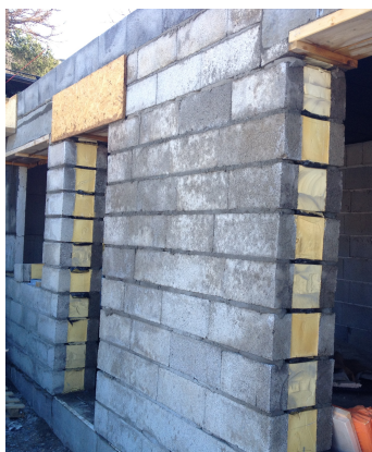
Figur 12 – Kjellervegg. Høyden er justert med hjelp av tykke fuger.
