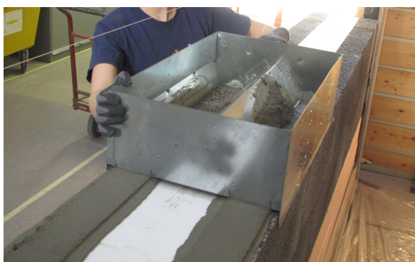
Figur 7 – Muring med mørtelkasse
