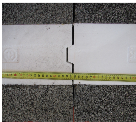
Figur 10 – Åpen stussfuge, ca. 4 mm
