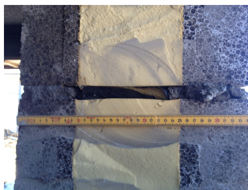
Figur 15 – Mørtelfuge går 10-20 mm inni laftestrimmel.
