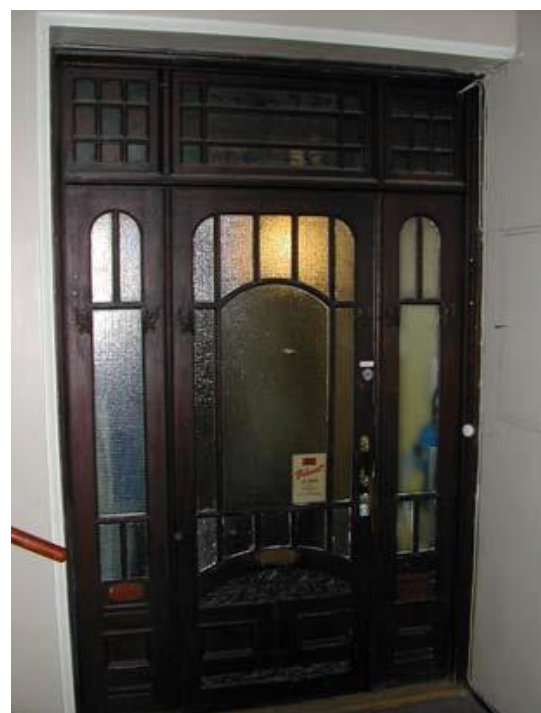
Figur 4 Eksempel på original trapperomsdør (Oslo brann- og redningsetat, 2007)
