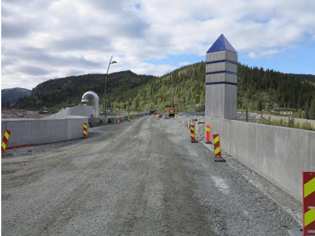
Figur 31: Dam Tunhovd - topp av dam med fylkesveg nærmer seg ferdigstilt (foto: Statkraft).
