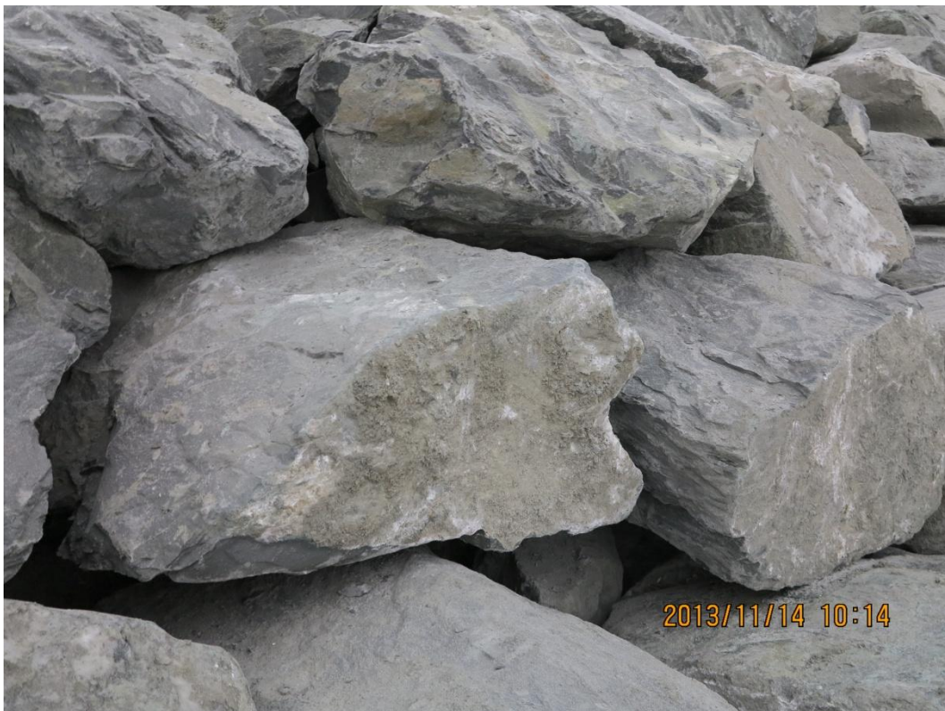
Figur 17: Detaljbilde av plastring med jevn steinstørrelse og god forband mellom steinene (foto: Norconsult).
