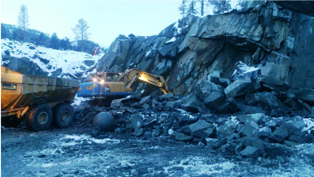
Figur 14: Utlasting av storstein etter salvesprengning. Foran gravemaskinen vises en stålkule som brukes for å dele opp for store steinblokker.
