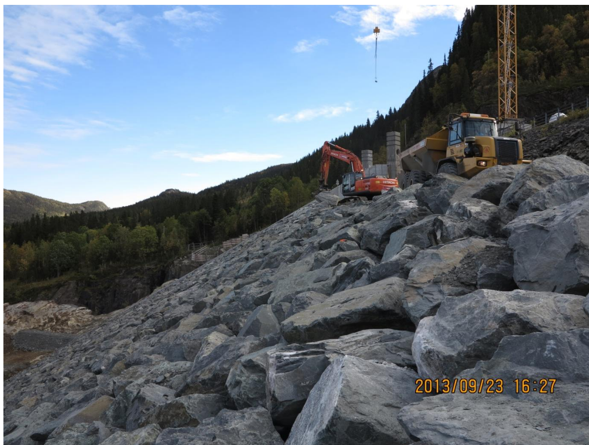
Figur 16: Plastringsarbeid på Tunhovd Dam (foto: Norconsult).
