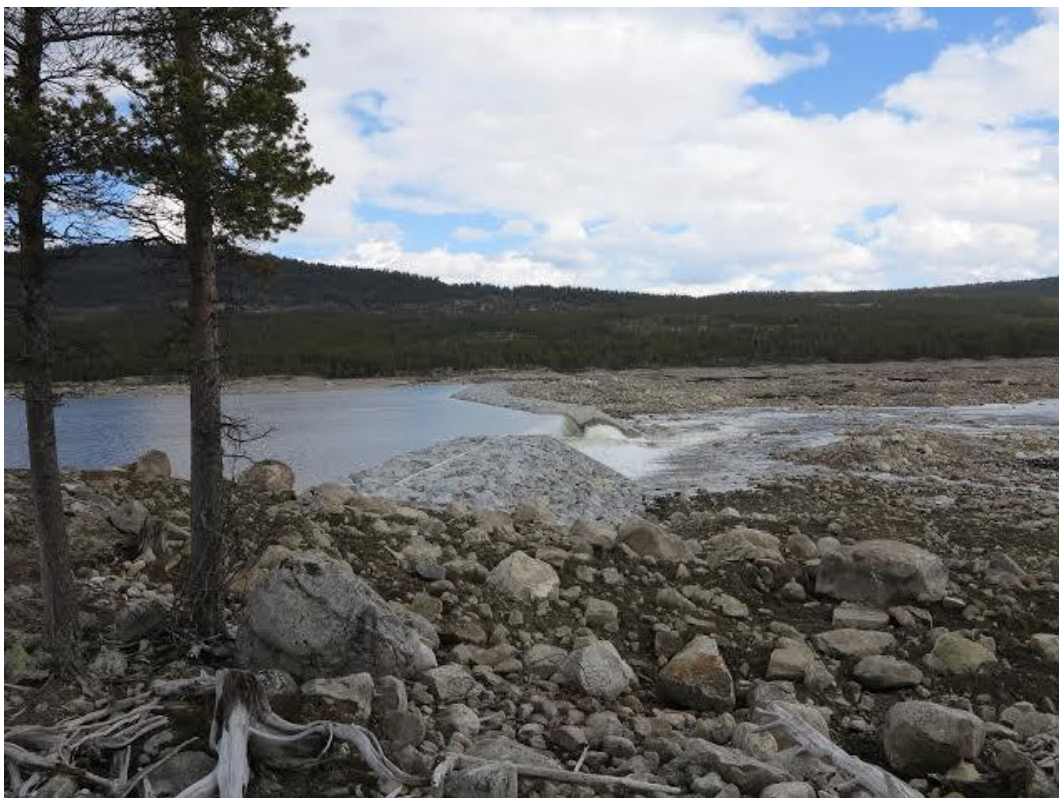
Figur 30: Pålsbu terskeldam etter ferdigstillelse (foto: Statkraft).
