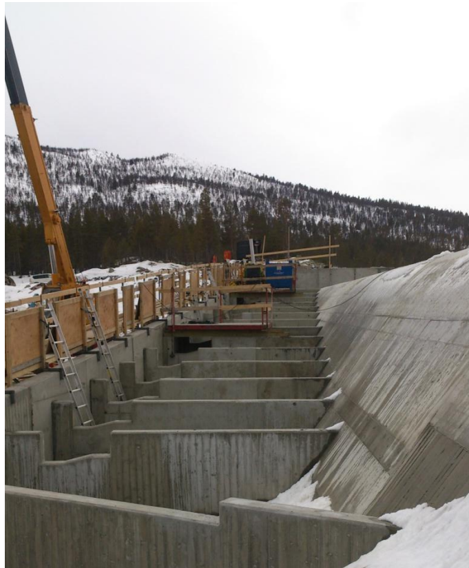
Figur 27: Overløpsterskel og fisketrapp under bygging.
