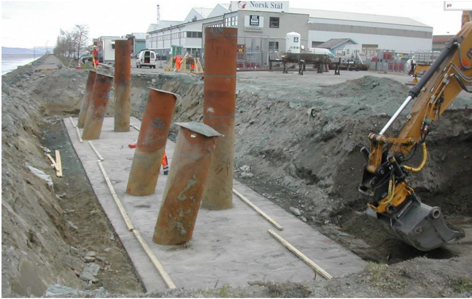
Figur 69 – Åpen og lukket Ø813 stålrørspel ved østre landkar av Pirbrua i Trondheim. Kopiert fra Statens Vegvesens nettsider (Vegvesen, 2009)..
