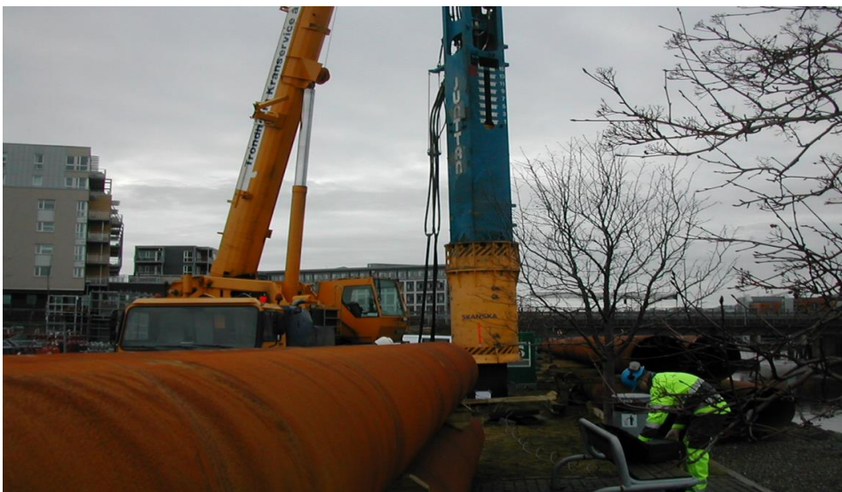
Figur 68 – Testing av Ø813 stålørspeler med 12 tonns fallodd. Kopiert fra Statens Vegvesens nettsider (Vegvesen, 2009).
