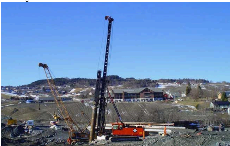
Figur 5-3. Ramming av stålrørspeler for Rossvollbrua (Haavardsholm, 2005)
