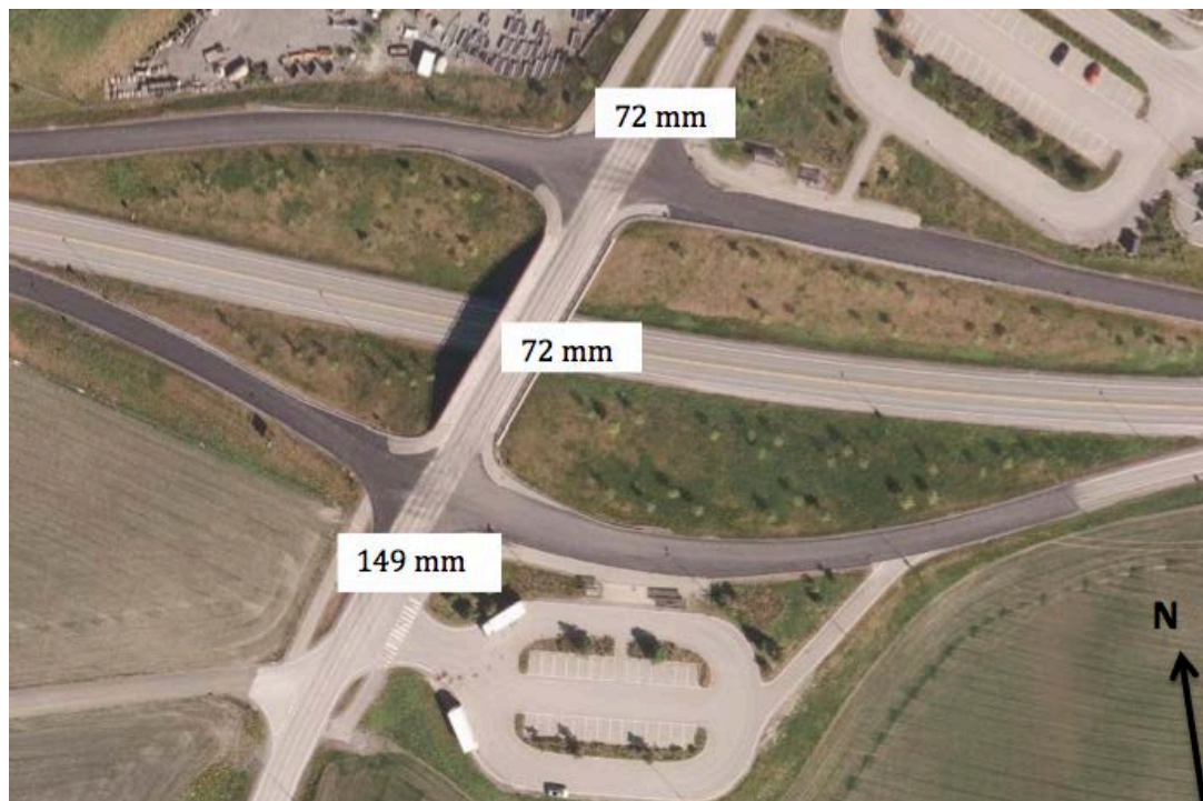
Figur 6-13. Målte setninger Overgangsbru Børsa 2011 (Google maps, 2010)
