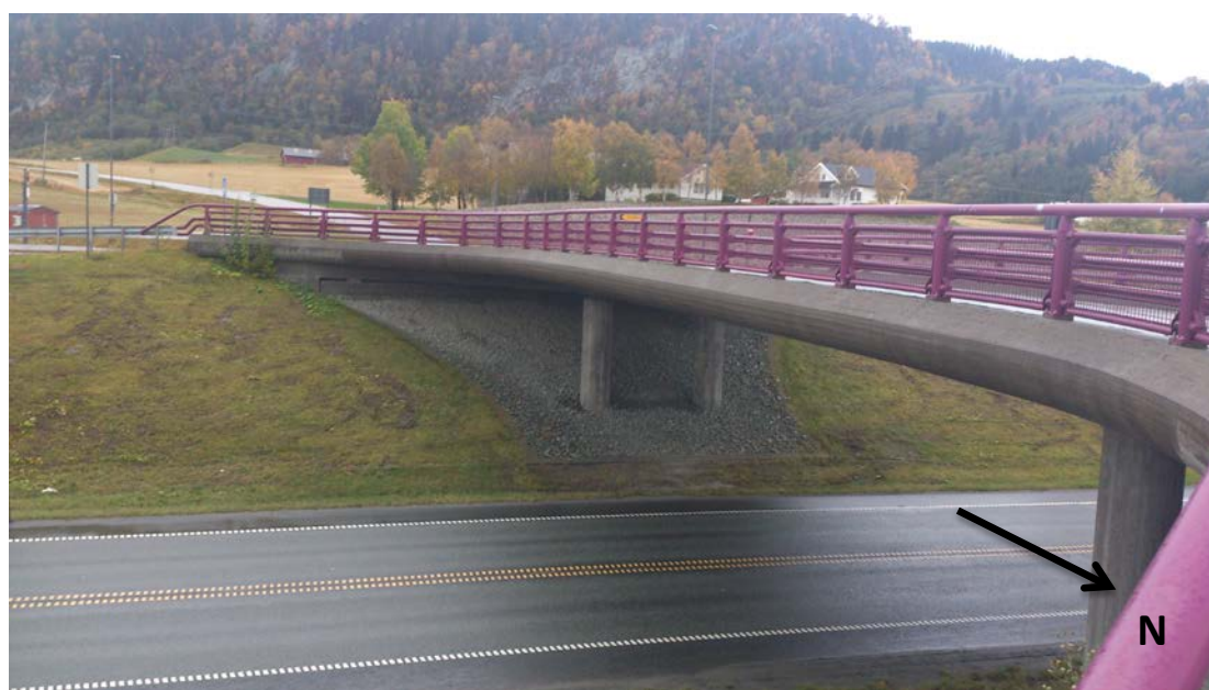
Figur 4-3. Overgangsbru Buvika (Bratlie, 2013)
