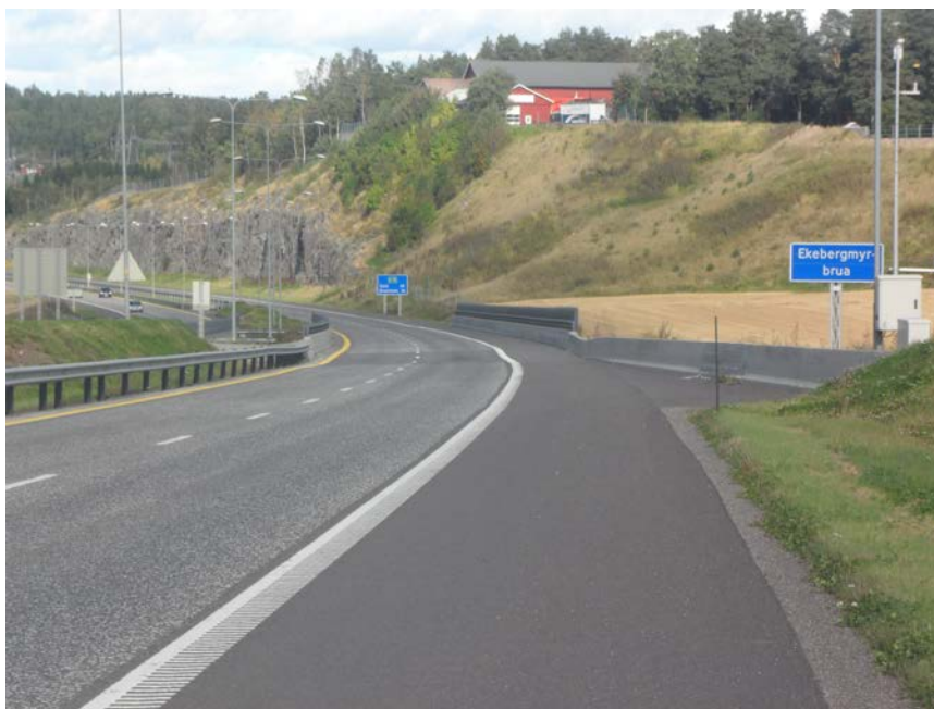
Figur 1-2. Setninger inn mot Ekebergmyrbrua, E18 Vestfold (Bratlie, 2012)
