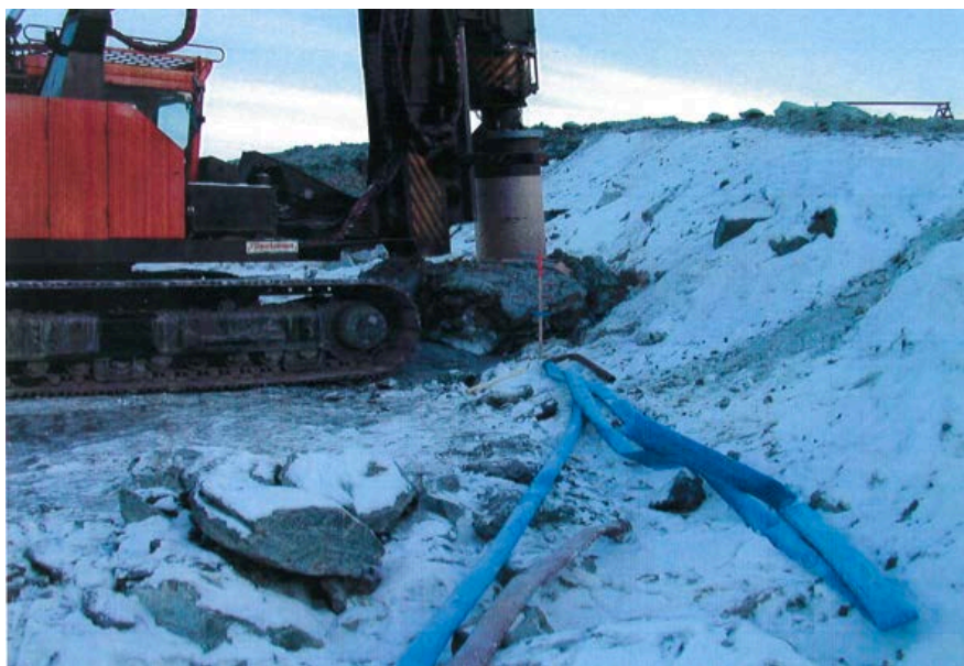
Figur 4-5. Installering av peler Hammerdalen (Hove, 2004)
