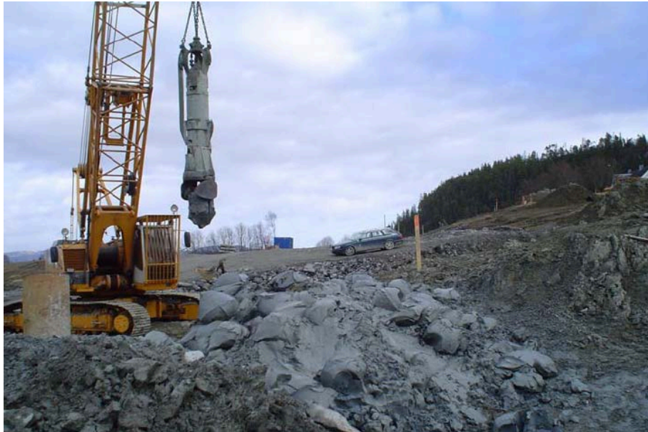
Figur 5-4. Grabbing av leire i stålrørspeler (Haavardsholm, 2005)
