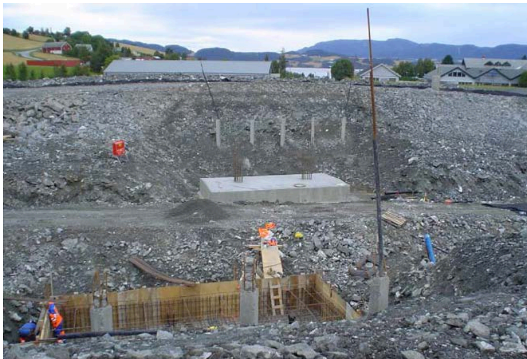
Figur 5-6. Installering av peler for Overgangsbru Børsea (Haavardsholm, 2005)
