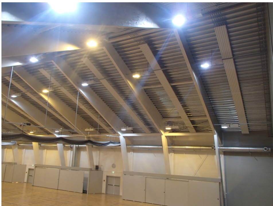
Figur 4.8: Trebjelkene i taket i Rollagshallen som spenner over 25 meter
