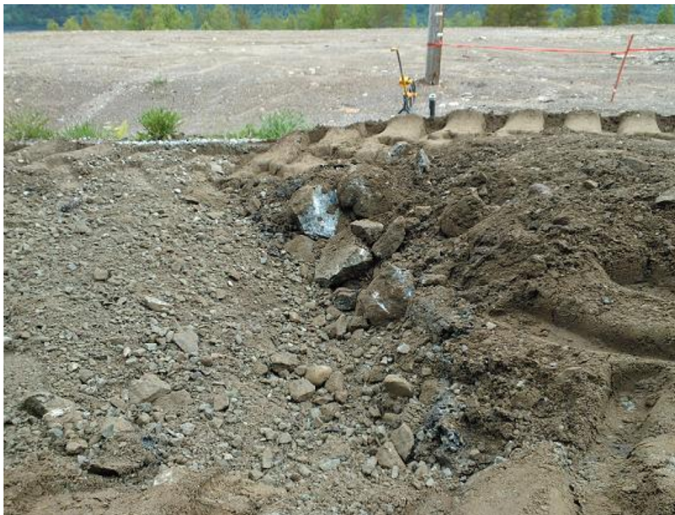
Figur 1 - Stor stein i bærelag ved fresing
