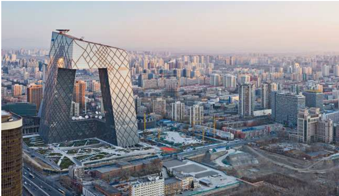
Figur 3.4-1: CCTV Hovedkontor av OMA, fasade mot syd [91]
