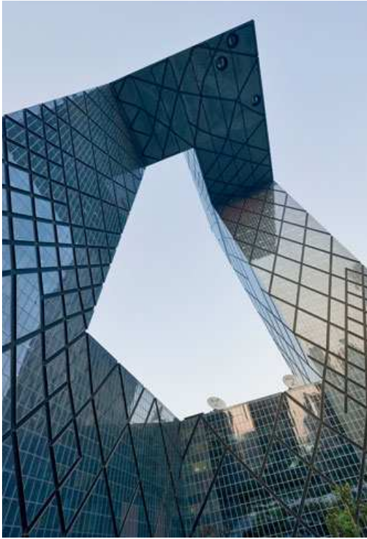
Figur 3.4-2: CCTV Hovedkontor under utkrager [91]
