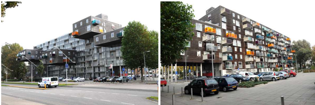
Figur 2.2-6: Wozoco, fasade mot nord [21] Figur 2.2-7: Wozoco, fasade mot syd [21]
