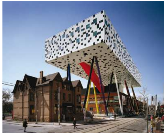
Figur 1.1-3: Eksempel på mer utfordrende arkitektur, The Sharp Center [4]
