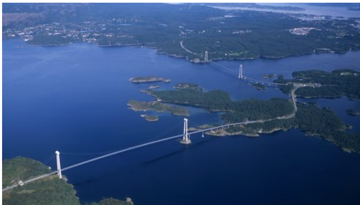
Figur 7.9: Flyfoto av Trekantsambandet (Bjoland & Rommetveit, 2013).
