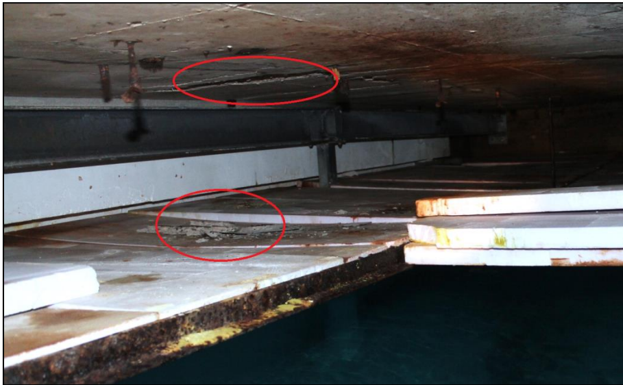
Bilde 9, øverst: Korroderte stålkomponenter. Oppsamling av smuss langs vannkanten på veggene i utjevningsbassenget.
