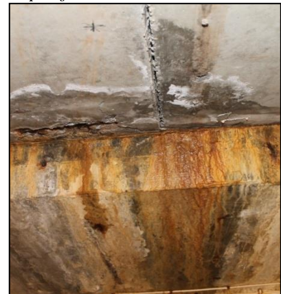
Bilde 12, over: lekkasje fra renna Bilde 13, under: lekkasje ved støpeskjøt
