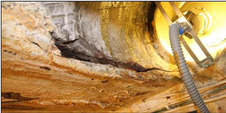
Bilde 10, over: korrodert armering stikker ut. Bilde 11, under: avskalling og lekkasje ved kuøye.
