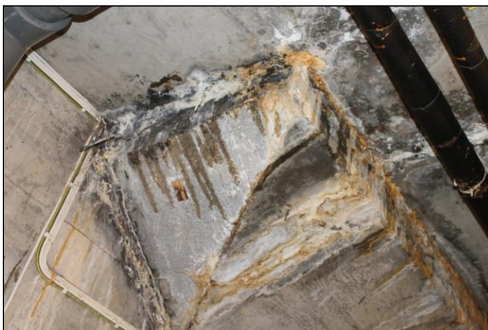
Bilde 4, øverst til venstre: Fuge mangler mellom flisene på dekket og stålbeslag nede i renna.
