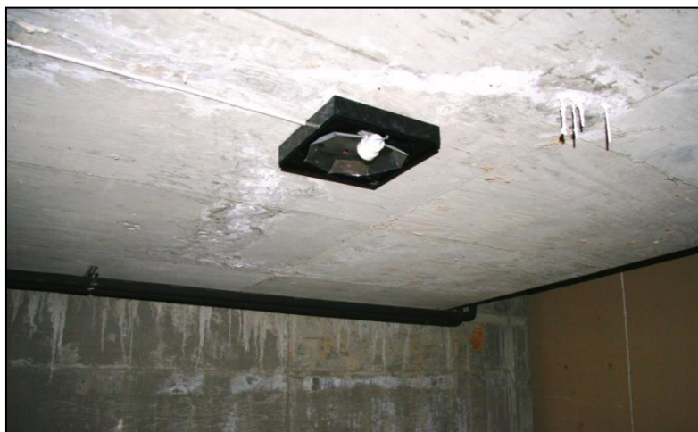
Bilde 7, over: Kalkutslag og fuktmerker under bassengtrauet og fra toppen av støttevegg under bassengtrauet.
