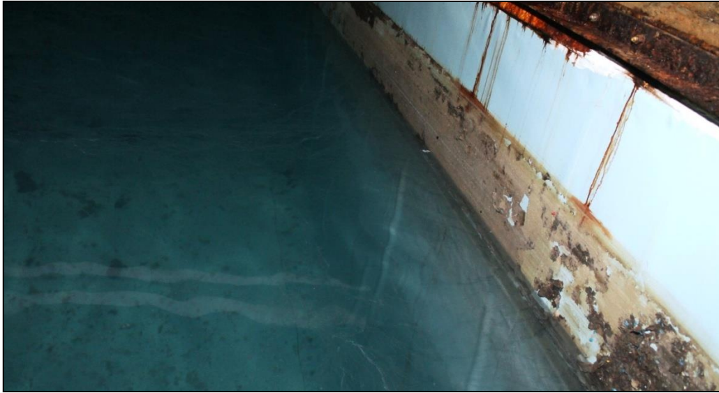
Bilde 9, øverst: Korroderte stålkomponenter. Oppsamling av smuss langs vannkanten på veggene i utjevningsbassenget.
