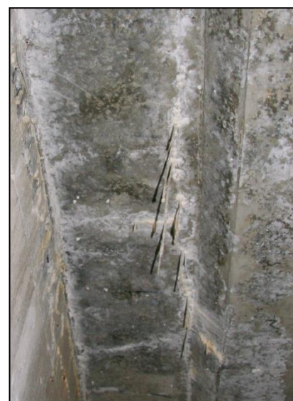
Bilde 7, over: Kalkutslag og fuktmerker under bassengtrauet og fra toppen av støttevegg under bassengtrauet.
