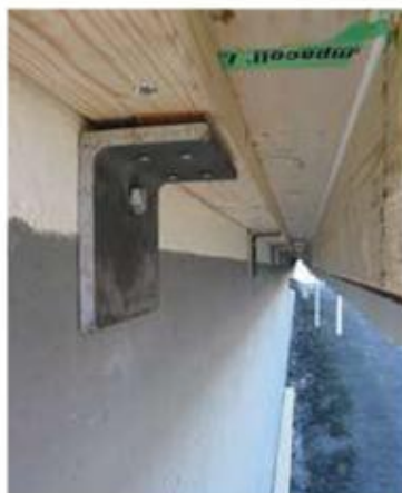
Figur 11. Utvendig innfesting av fasadeelement (Time, 2013)
