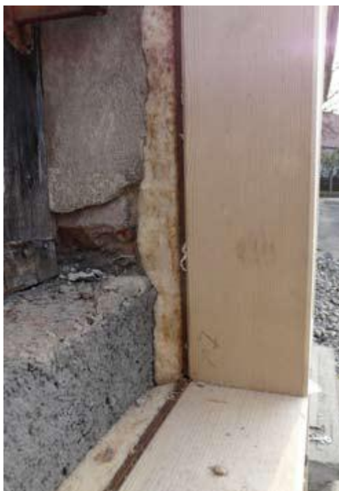
Figur 4. Utjevningssjikt av isolasjon (Lattke et al. 2009).
