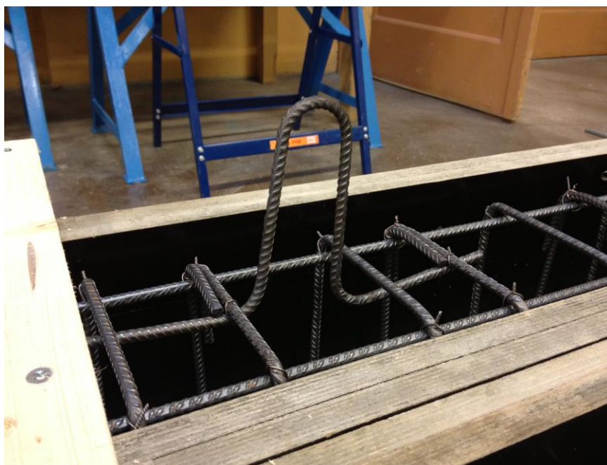
Figur 17 Løfteøye for transport av bjelke
