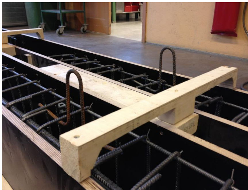
Figur 18 Avstiver til forskaling
