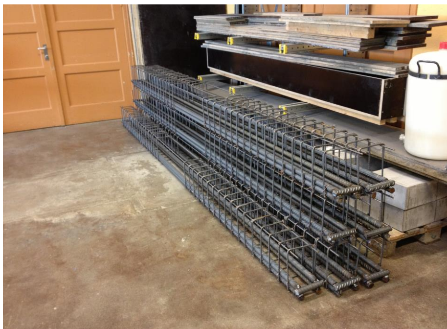
Figur 14 Ferdig armerte bjelker
