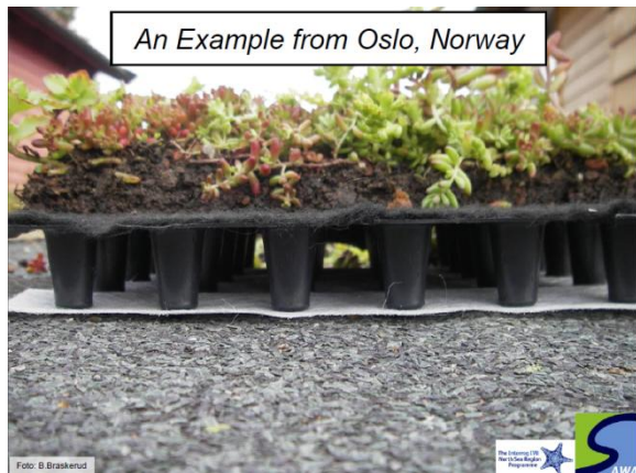
Figur 5.27: Nedbørslagring ved lette vegeterte tak (Paus, 2012).
