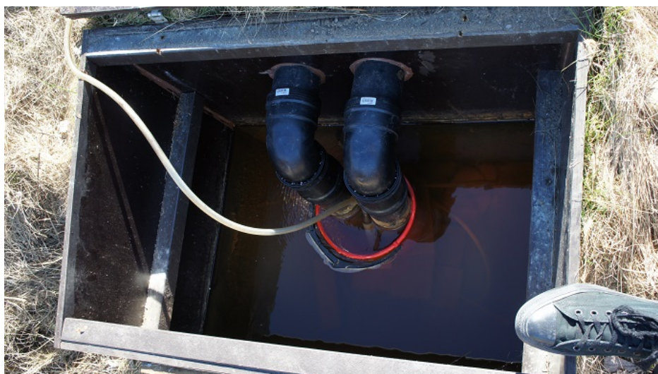
Figur 3.7: Prøver av utløpsvannet ble tatt fra en bøtte i dreinsboksen.
