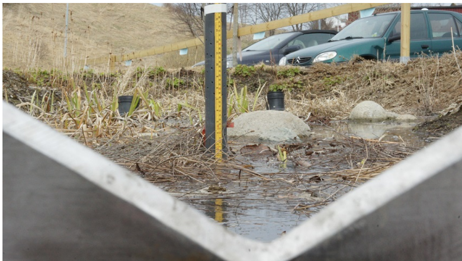
Figur 3.11: Vannstanden i regnbedet måles i et perforert vannstandsør oppstrøms overløpet.
