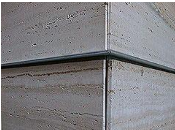
FIGUR 3.2-14 TYNNPLATEKLEDNING AV TRAVERTIN MONTERT MED KONTINUERLIG HORISONTALT SKINNESYSTEM (ALNÆS, 2004)
