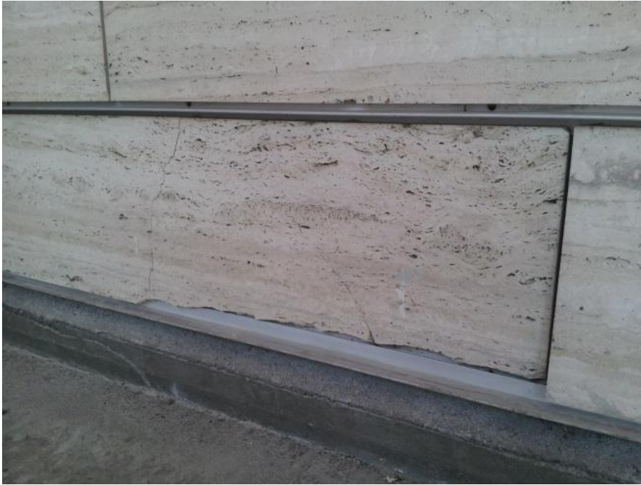
FIGUR 4.2-3 NATURSTEINSFASADE I SKINNESYSTEM MED PÅKJØRSELSKADE(EKNES, NATURSTEINSFASADE [FOTO])
