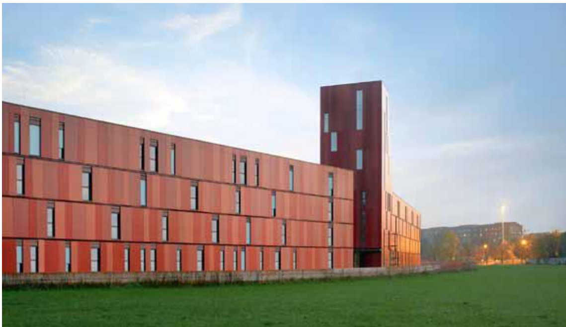
FIGUR 3.2-1 PÅHENGSFASADE FRA SWISSPEARL (SWISSPEARL ARCHITECTURE 15, UDATERT)
