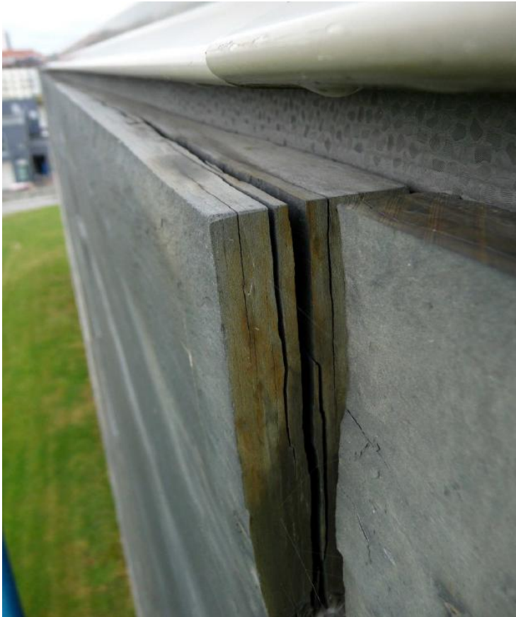
FIGUR 4.2-2 DELAMINERING AV SKIFTER (VEDLEGG 7)
