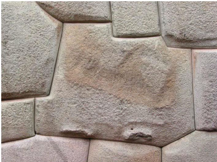
FIGUR 3.2-9 I DET 15. ÅRHUNDRE BYGDE INKAENE I PERU MED MEGET PRESIST TILDANNEDE STORE STEINER UTEN BRUK AV MØRTEL (BRANDT, 2009)
