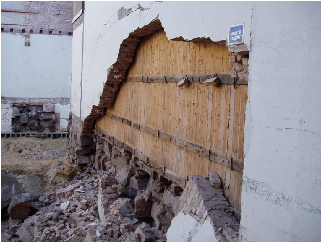
FIGUR 4.2-4 UTRASING AV TEGLFORBLENDING PÅ GRUNN AV SETNINGER (VEDLEGG 8)
